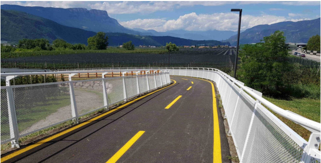
Figura 29 Ponte ciclabile strallato sulla SS.12 in località Pineta di Laves
