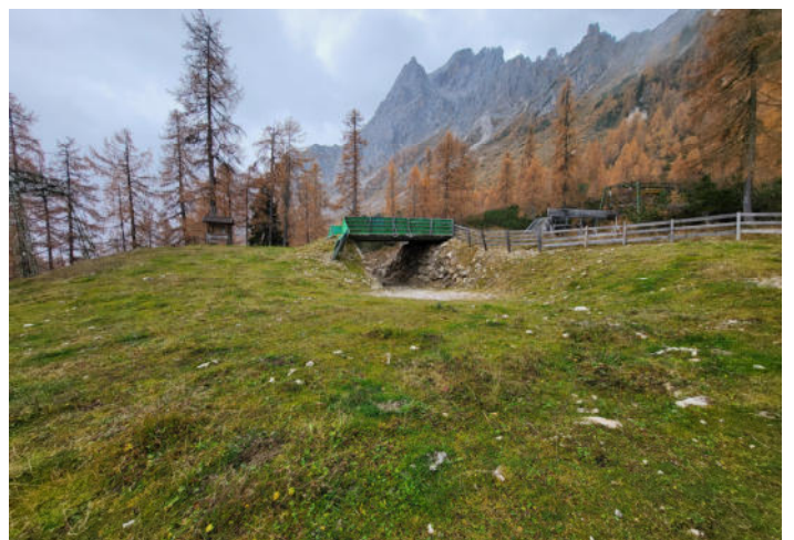
Bereich alte Bergstation PORZEN
