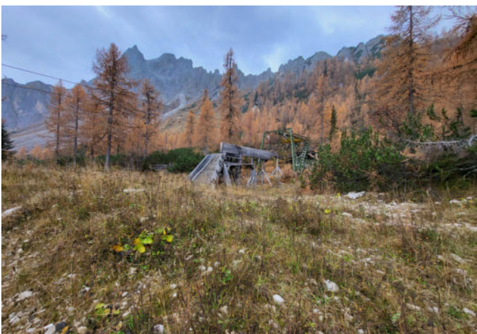
Bereich alte Bergstation PORZEN
