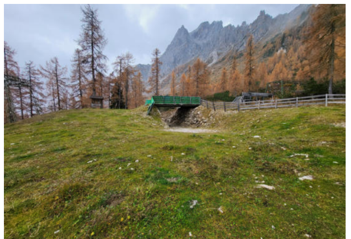
Bereich alte Bergstation PORZEN
