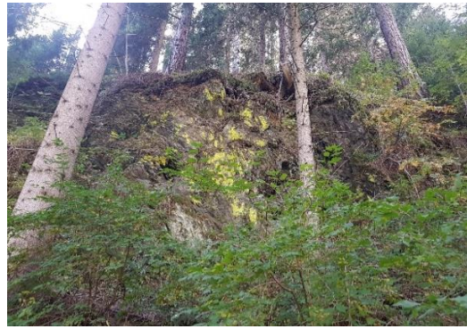
Bild 22: Felswand - Nordseite des Tunnelportals, ca. 30 m vom Tunnelportal entfernt.
