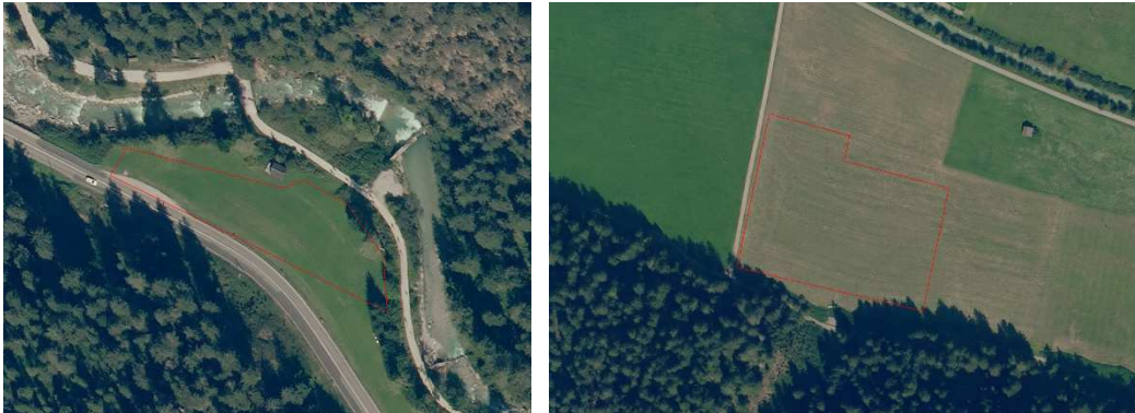
Figura 28. Aree di cantieri presso i portali Sud (sinistra) e Nord (destra).
