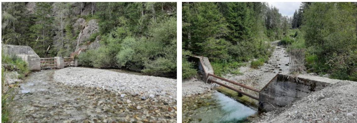
Figura 5. Alcune immagini delle briglie filtranti esistenti lungo il Rio di Sesto nei pressi del sito in cui è prevista la realizzazione dell'opera di diversione e del portale Sud del nuovo tunnel stradale.
