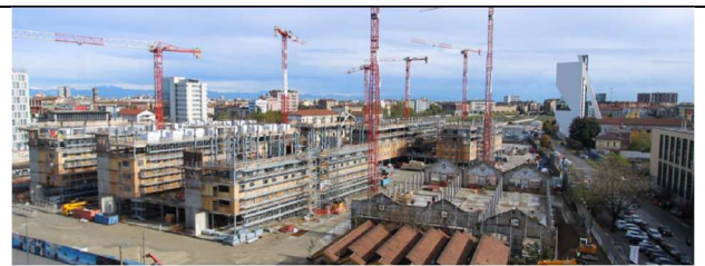
Figura 5.8 – Milano Olympic & Paralympic Village - cantiere costruzione a inizio novembre 2023
