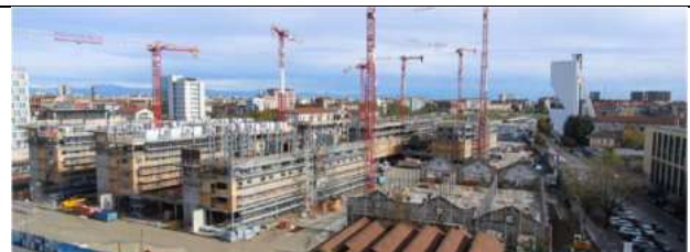
Figura 3.8 – Milano Olympic & Paralympic Village – cantiere costruzione a inizio novembre 2023
