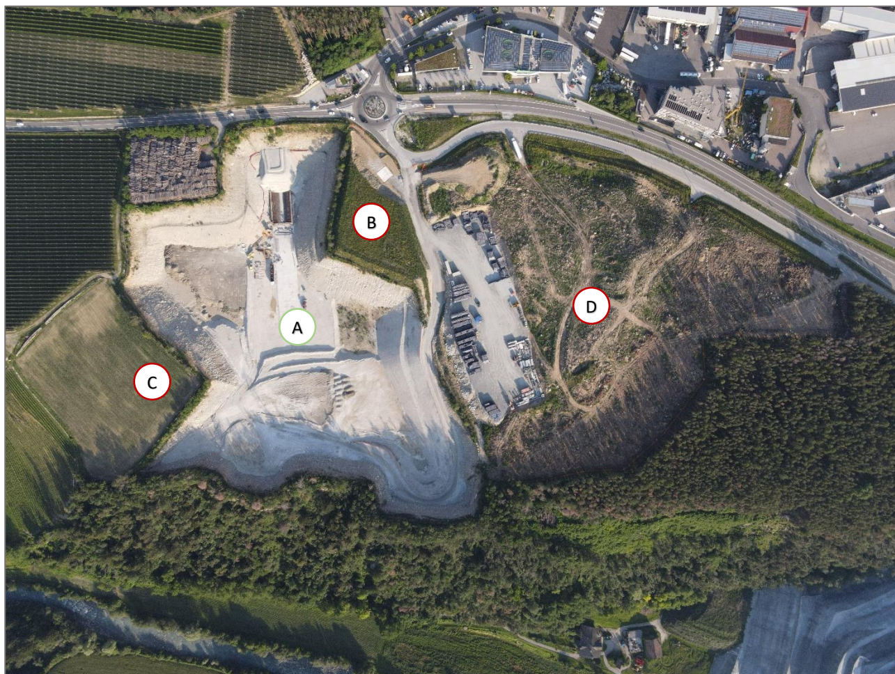
Figure 4-3 Stato attuale delle aree oggetto di intervento
