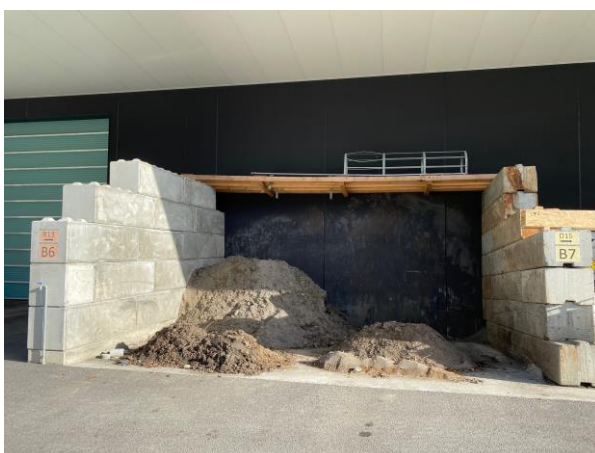
Abb. 8: Abfallbunker B6 für die Abfalltätigkeit D13 (Vermengung und Vermischung von Abfällen)
