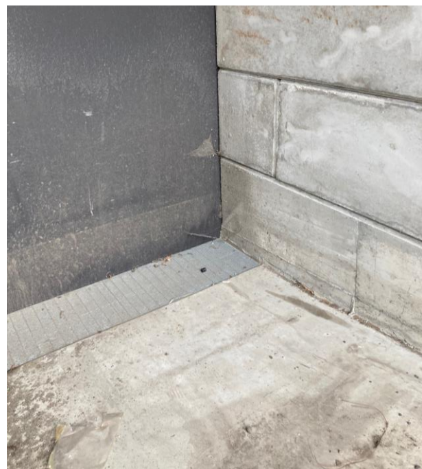
Abb. 11: Sickerwasserrost im Abfallbunker B6
