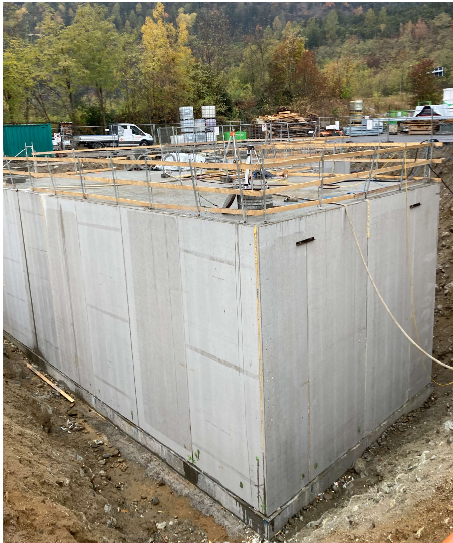
Abbildung 9: Neues Speicherbecken (während dem Bau)
