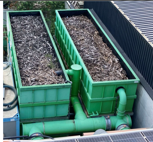
Abbildung 8: Realisierte Biofilteranlage
