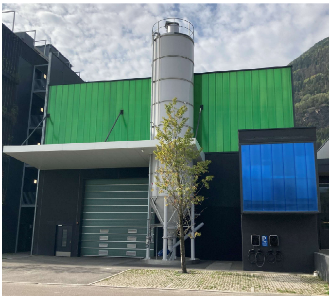
Abbildung 3: Kalklagersilo für nachfolgende Kalkmilchmischanlage
