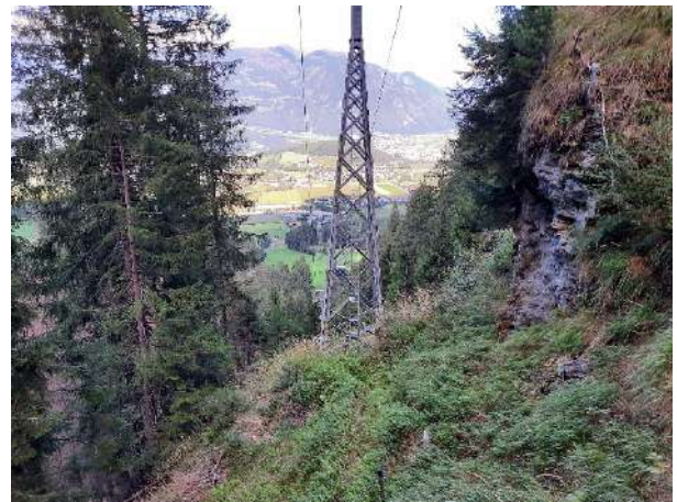
Baufläche von Stütze 9 „Kronplatz 1“ im Bereich der bestehenden Stütze 12.
