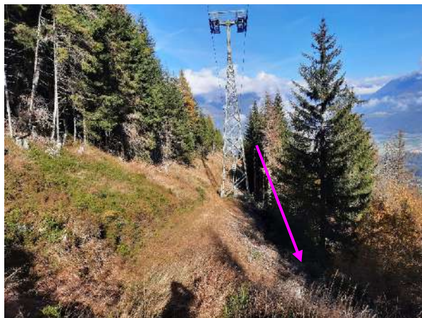
Baufläche von Stütze 3 „Kronplatz 2“.
