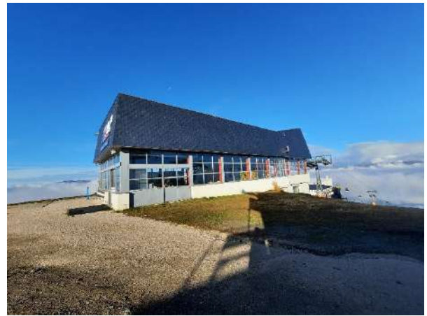
Südostansicht der bestehenden Bergstation.
