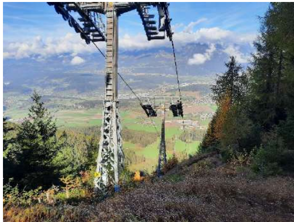
Baufläche von Stütze 12.
