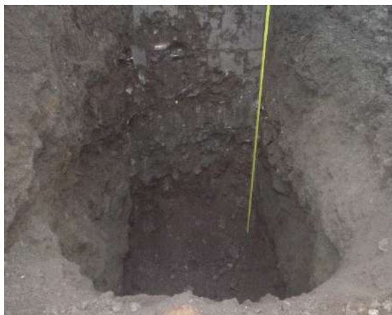
Foto 1: Murschuttsedimente in einem Bagger-schurf im Nahbereich der Talstation.
