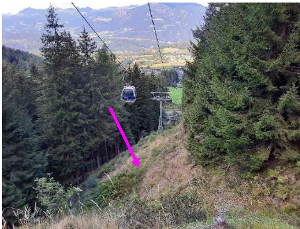
Baufläche von Stütze 8 „Kronplatz 1“.
