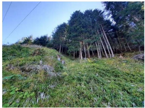
Übergang in die tiefgründige Massenbewegung (linker Bildausschnitt) rd. 20 m bergseitig des geplanten Stützenstandorts.
