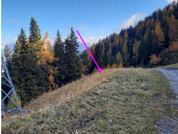
Baufläche von Stütze 5 „Kronplatz 2“.
