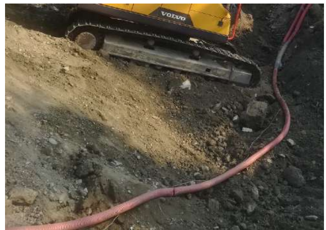
Foto 2: Murschuttsedimente in einer Baugrube im Nahbereich der Talstation.
