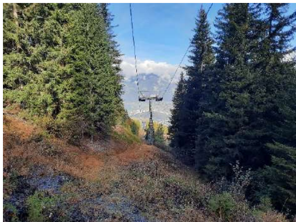
Baufläche von Stütze 3 „Kronplatz 2“ mit leicht erkennbarer Ausbauchung bergseitig der Stützenposition.
