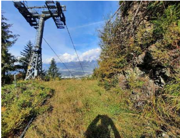
Baufläche von Stütze 10 „Kronplatz 1“ im Bereich der bestehenden Stütze 13.
