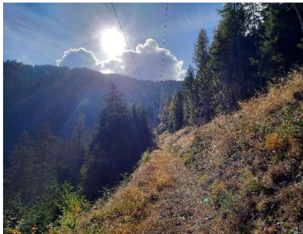
Baufläche der und Mittelstation und Stütze 1 Kronplatz 2.
