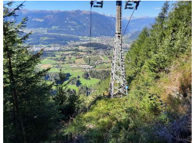
Baufläche von Stütze 11 „Kronplatz 1“ talseitig der bestehenden Stütze 15.
