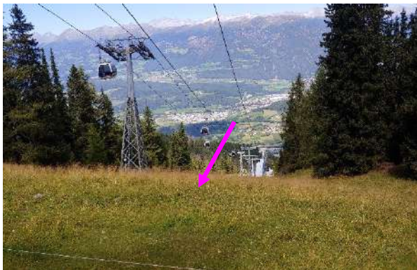
Baufläche von Stütze 6.
