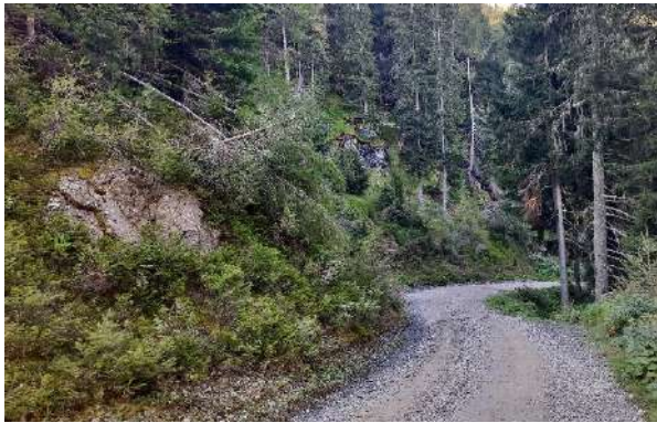
Anstehender Quarzphyllit westlich der geplanten Piste im Bereich der Forststraße „Korer“.
