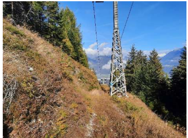
Baufläche der Mittelstation mit Blick in Richtung Norden.
