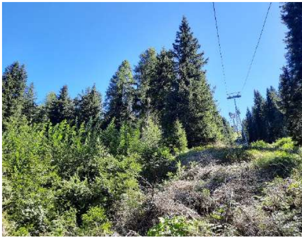
Baufläche von Stütze 4 „Kronplatz 2“.
