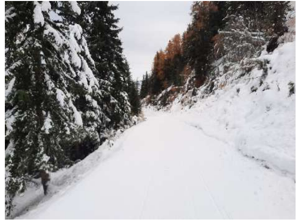
Bestehender Skiweg entlang des bergseitig steilen Böschungsanschnitts.
