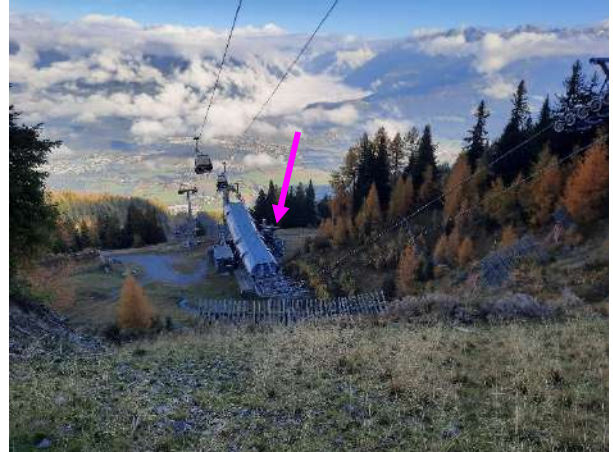
Übersichtsfoto der bestehenden Mittelstation mit Position der geplanten Stütze 5 „Kronplatz 2“ (Pfeil).
