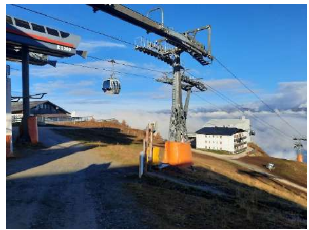
Baufläche der Stützen 11 und 12 direkt talseitig der bestehenden Bergstation.
