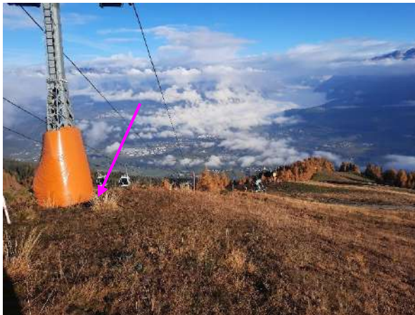
Baufläche von Stütze 8 „Kronplatz 2“.
