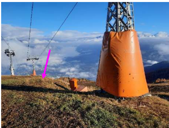
Baufläche von Stütze 10 „Kronplatz 2“.
