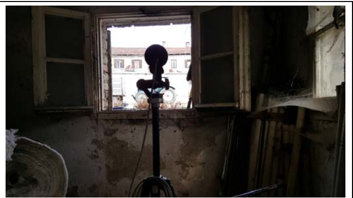
Foto installazione interna, vano cantina finestra aperta. Foto Aufbau der Messanlage des Wohnhauses, offenes Fenster
