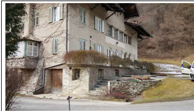
Foto installazione esterna Foto Aufbau der Messanlage im Inneren des Wohnhauses
