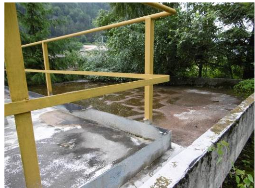
Copertura edificio "A7" – Dach Gebäude "A7"
