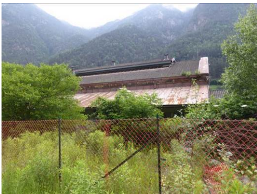
Copertura Deposito locomotive
