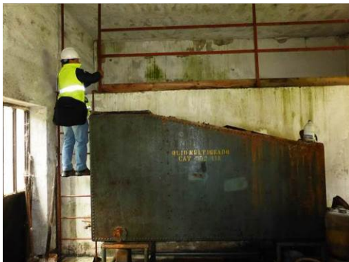
Rifiuti deposito olii
