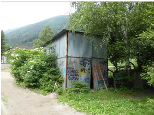
Baracca - Barackenlager „A8“
