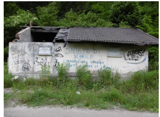
Copertura Edificio „A4“
