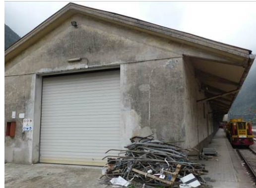
Edificio – Gebäude “A5”
