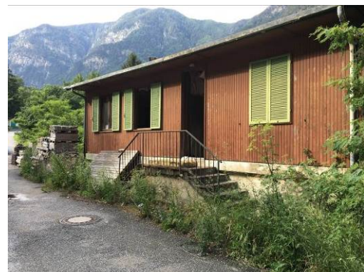
Prospetto edificio– Ansicht Gebäude - “C1”
