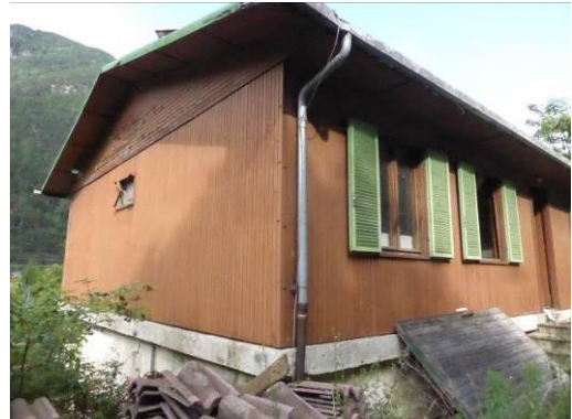
Prospetto edificio- Ansicht Gebäude - "C1"
