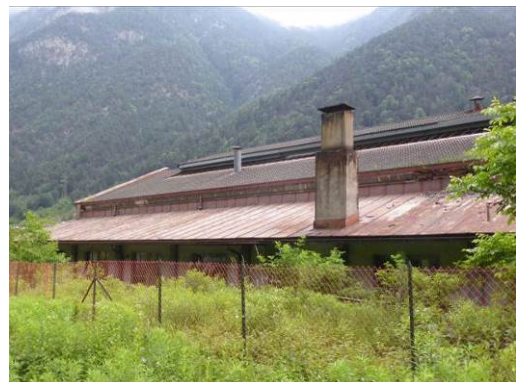
Copertura Deposito locomotive
