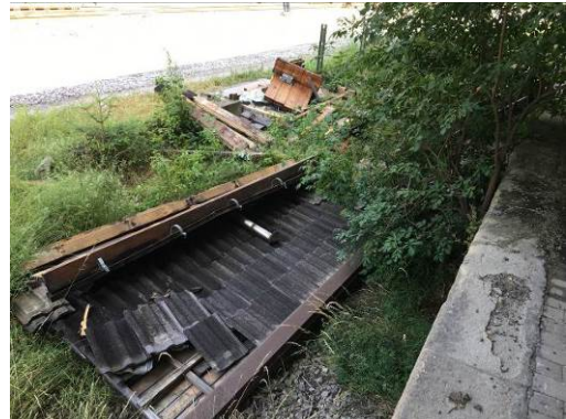
Porzione di copertura in legno e tegole
