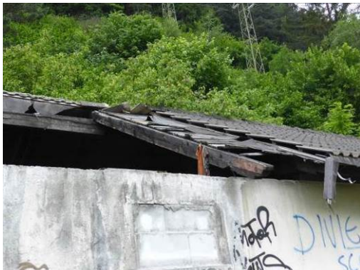
Copertura Edificio „A4“
