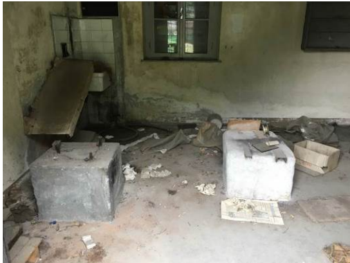
Rifiuti edificio „A1“
