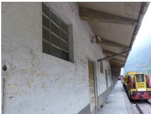
Edificio Gebäude „A5“ con binario tronco lato ferrovia
