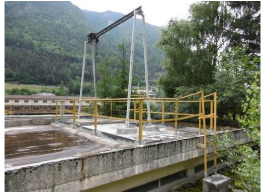
Copertura edificio "A7" – Dach Gebäude "A7"
