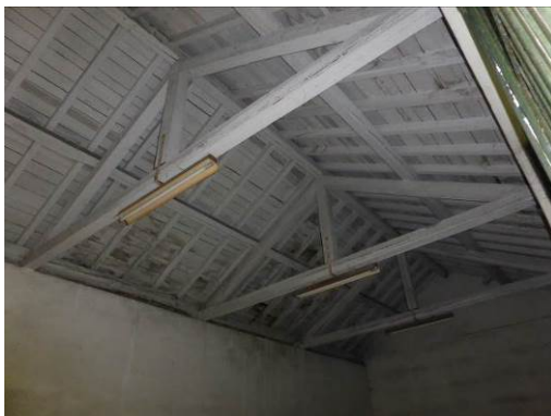
Vista interna del tetto in legno
