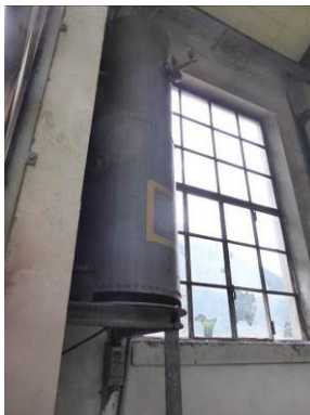
Serbatoio presente nella Rimessa
