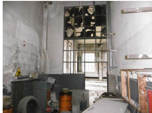
Rifiuti vano officina
