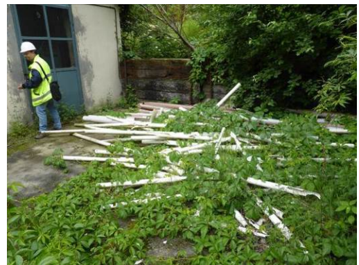
Edificio Gebäude „A6“ – Rifiuti esterni
