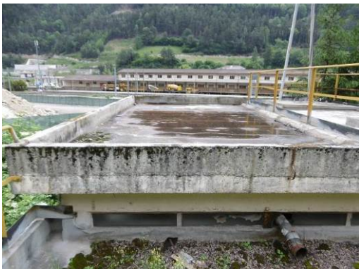
Copertura edificio "A7" – Dach Gebäude "A7"
