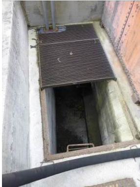
Botola di accesso alla vasca interrata
