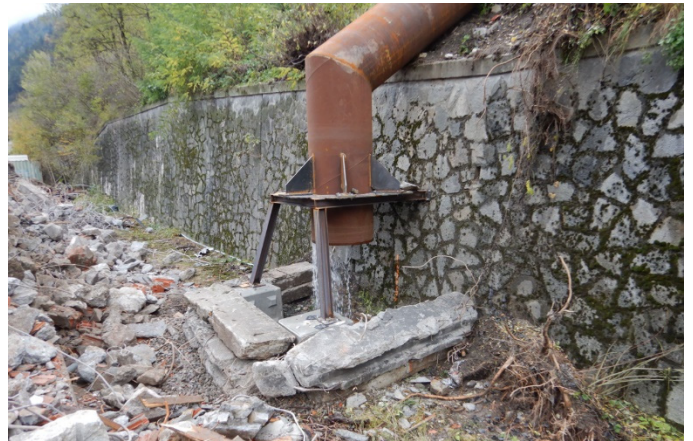
Illustrazione 7 parte by-pass in metallo da demolire
