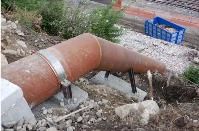
Abbildung 7: Metall-Bypass-Teil zu abbrechen
