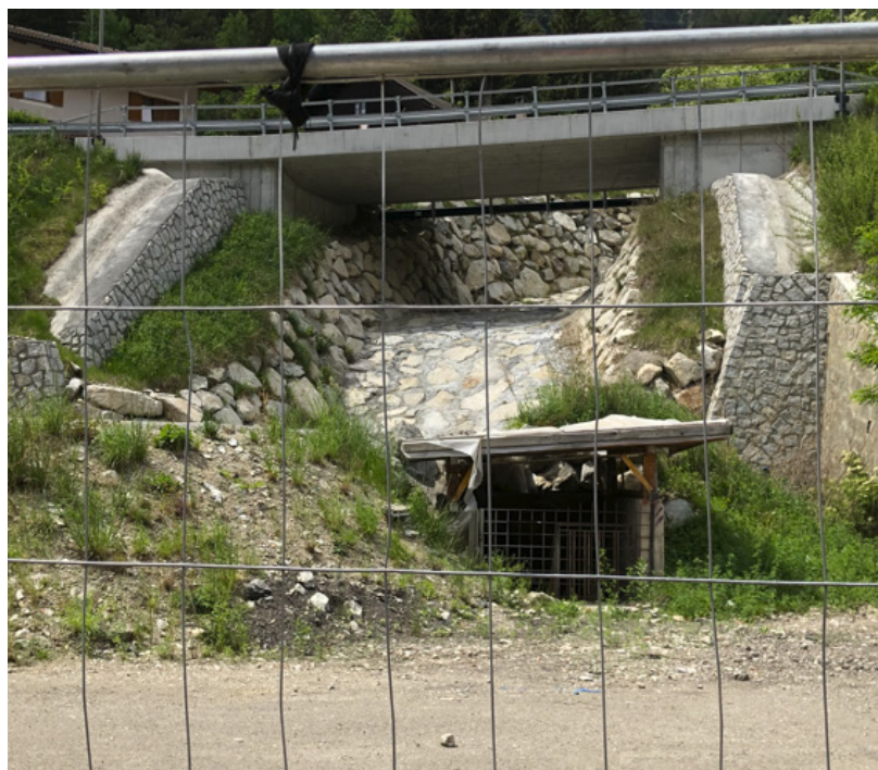
Abbildung 1: Zugang abzubrechende Unterführung
