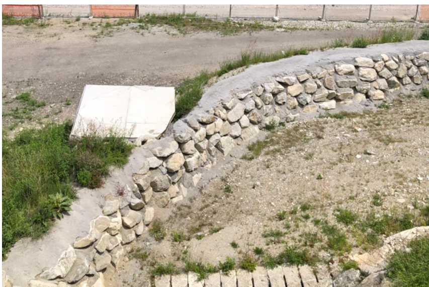
Abbildung 3: Uferbefestigung in Zyklopen
