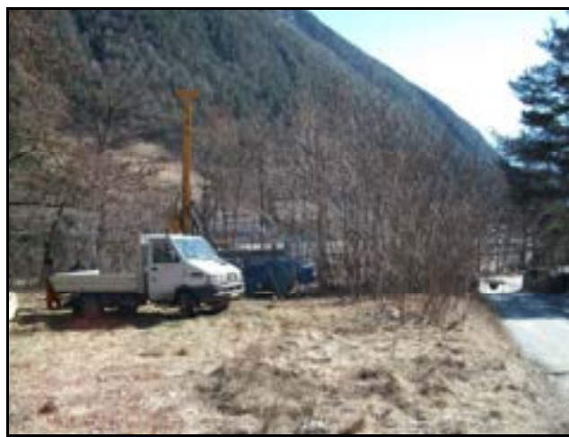
Abbildung 2: Foto der Bohrstelle
