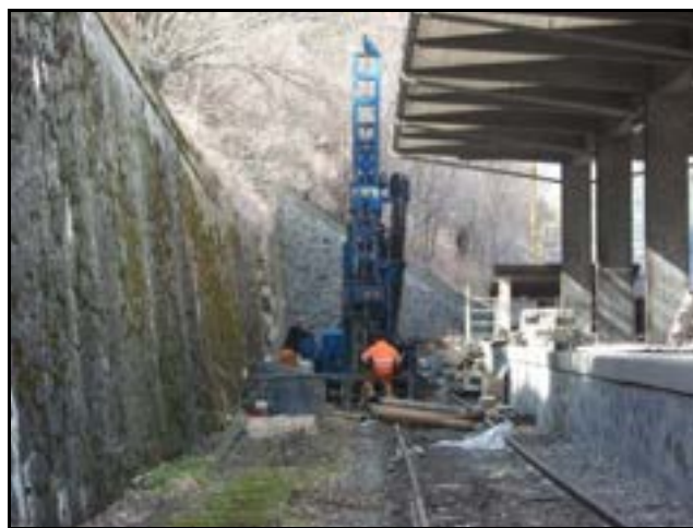
Abbildung 2: Foto der Bohrstelle
