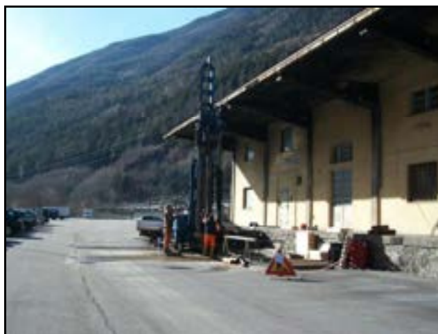
Abbildung 2: Foto der Bohrstelle
