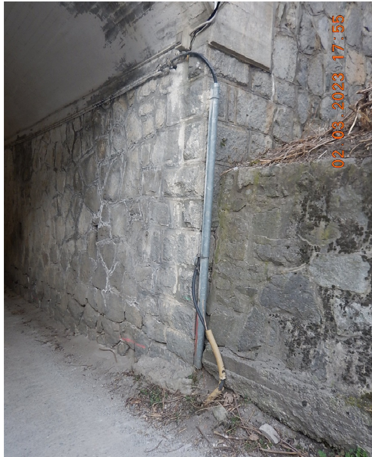
Abbildung 1: Telefonkabel an der Wand am bergseitigen Portal der bestehenden Unterführung
