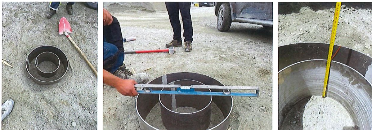
Figura 3. Fasi preparatorie (scavo, posizionamento e livellamento).
