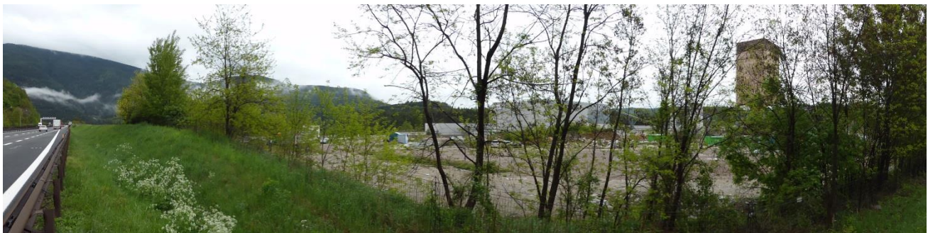
Abbildung 3: Sicht von der Autobahn auf den geplanten Standort
