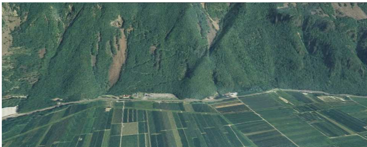
Bereich des offenen Abschnittes Auer, der Tunnelportale, des kurzen Zwischentunnels und der Baustelleneinrichtungsflächen
