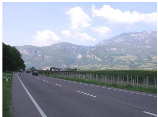
Landwirtschaftliche Flächen westlich der Staatsstraße Aree agricole a ovest della strada statale
