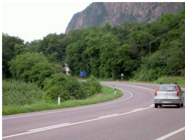
Nahbereich des Nordportals des Tunnels Auer Zona in prossimità del portale Nord della galleria Ora
