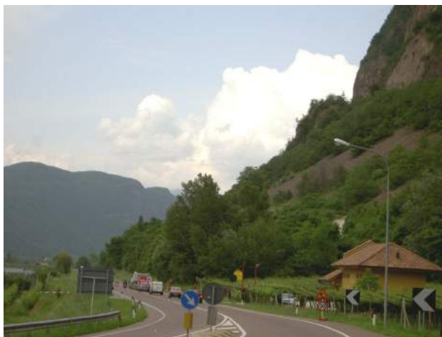
Bestehender Steinbruch am Hang östlich der Staatsstraße Cava esistente sul versante ad est della strada statale
