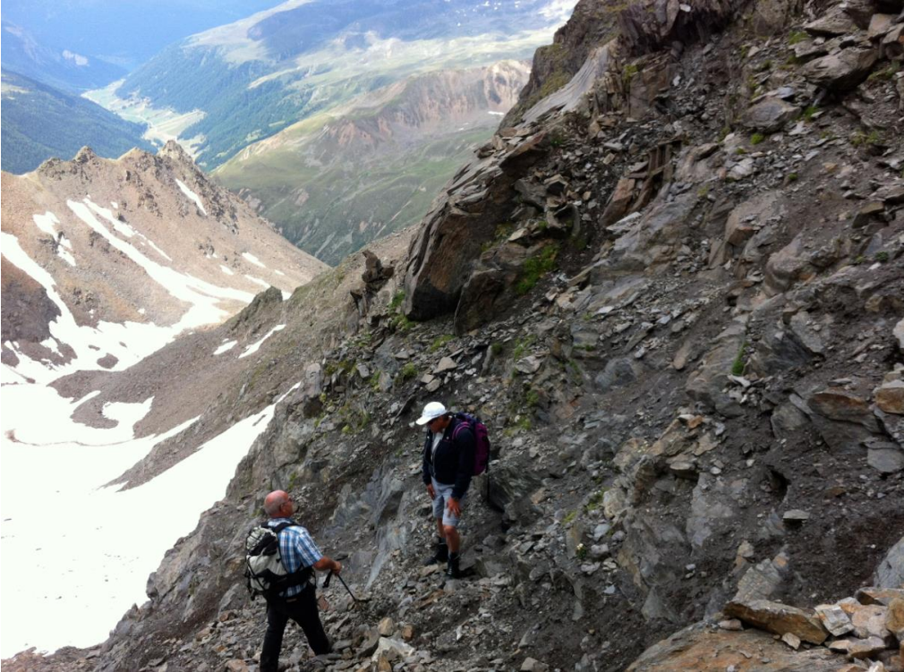
Foto 2- Particolare dell'ammasso roccioso in corrispondenza della stazione di monte
