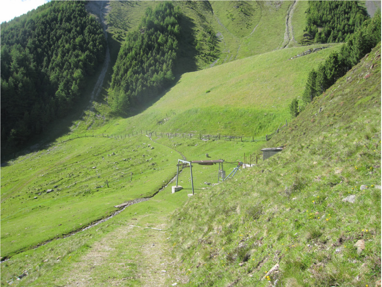
Foto 7: Ausblick auf die Bergstation des alten Skiliftes und der Lawinstaumauer
