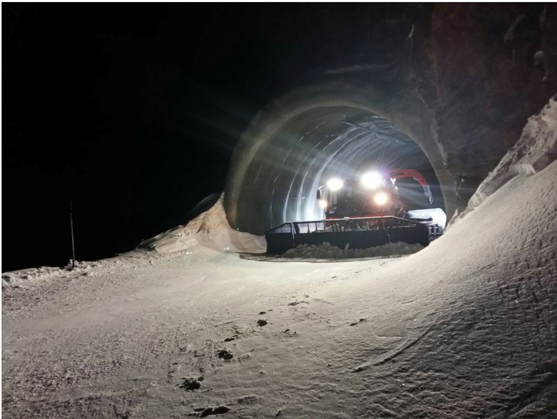
Abbildung 16 – Bestehende Skitunnel im Kaunertal
