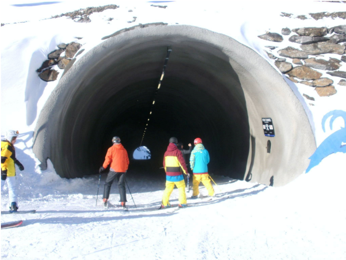
Abbildung 17 – Bestehende Skitunnel im Kautertal
