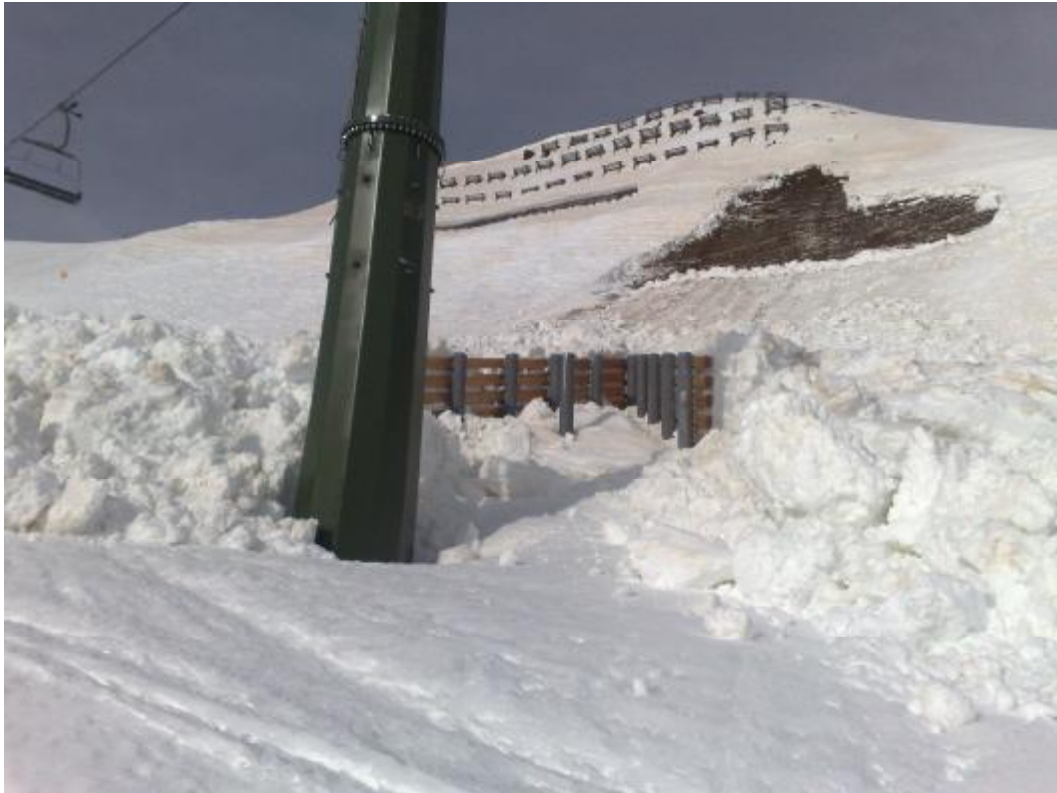
Foto D. Effetto di protezione esercitato dal cuneo sul sostegno della linea funiviaria.
