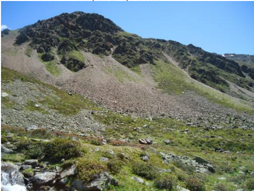
Foto 14. Panoramica della zona pericolosa cartografata per fotointerpretazione in C.L.P.V. in sponda sinistra, nel tratto precedente la piega della valle a nord-est. Gli scaricamenti non interferiscono ragionevolmente con la linea dell'impianto in entrambe le ipotesi progettuali.
