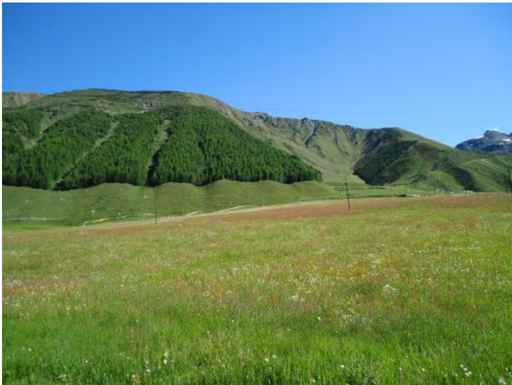
Foto 1. Panoramica del sito valanghivo n. 149 della C.L.P.V. Il settore occidentale (a sinistra nella foto) è stato bonificato mediante realizzazione di opere di stabilizzazione della neve in zona di distacco, estese fino all'interno dei canali di scorrimento.
