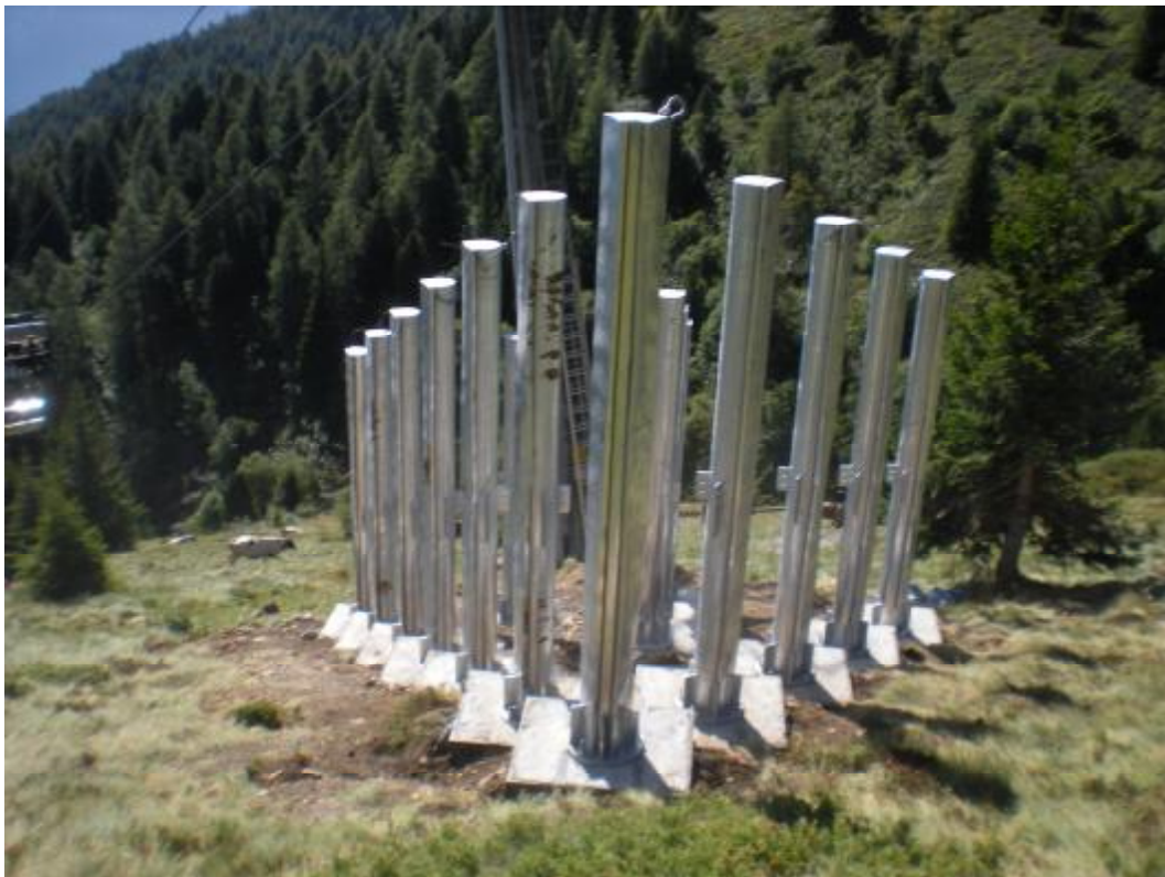
Foto B. Montanti metallici.
