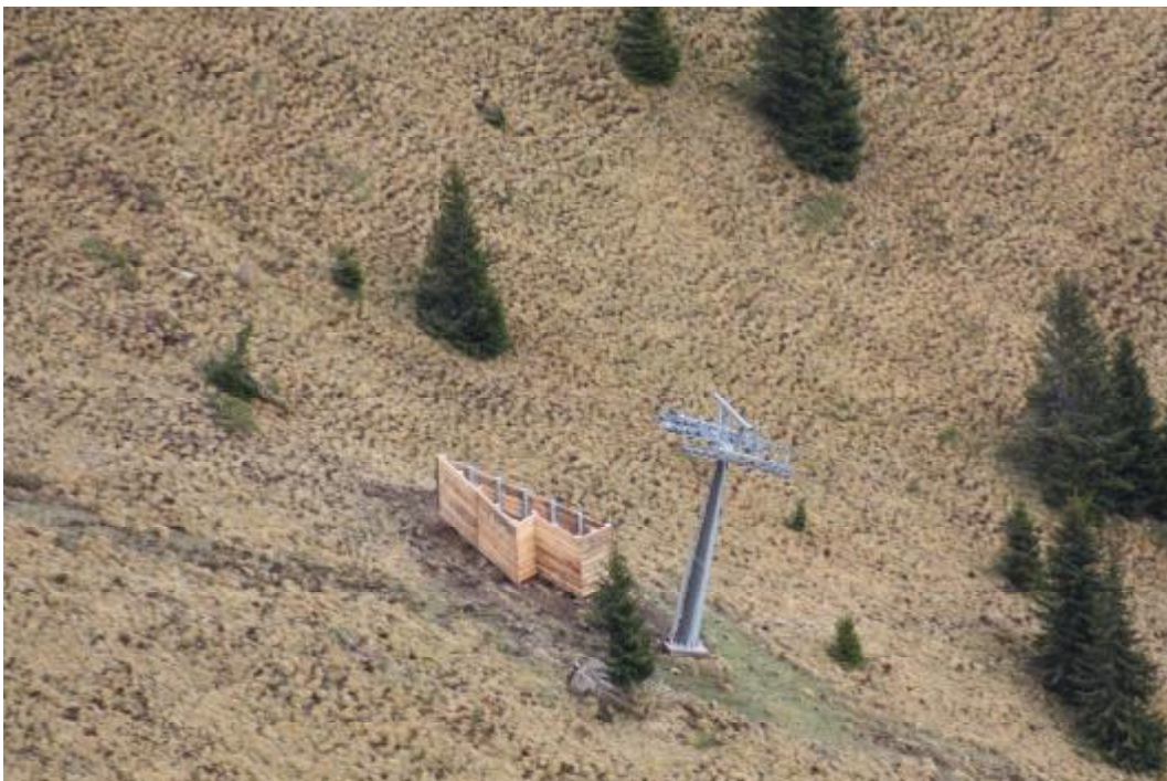
Foto C. Struttura ultimata, con paramento esterno in tavolato di legno.
