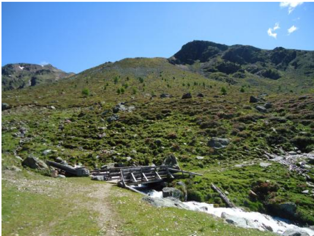
Foto 6. Ponticello sul Rio Melago a quota 2150 m/s.l.m. circa. Da questo punto, nella soluzione A, la pista in progetto si sviluppa direttamente sul fondovalle.
