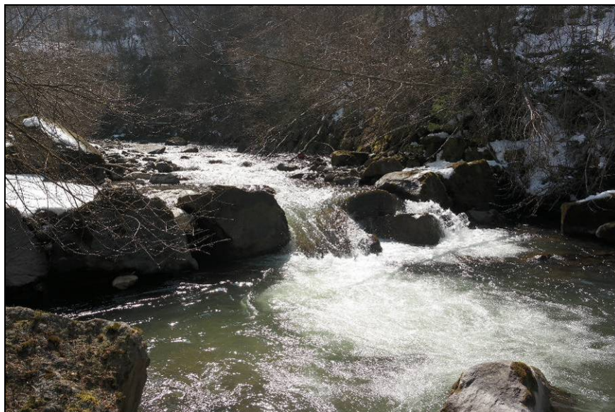
Figura 2.12 – Briglia 3 sul Rio Gardena/Grödnerbach, particolare
