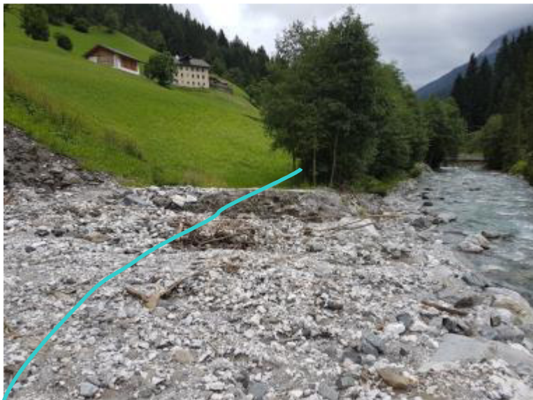
Foto 22: Die Linie kennzeichnet den Verlauf der Druckrohrleitung. Im Bild die Querung des Seitengrabens.
