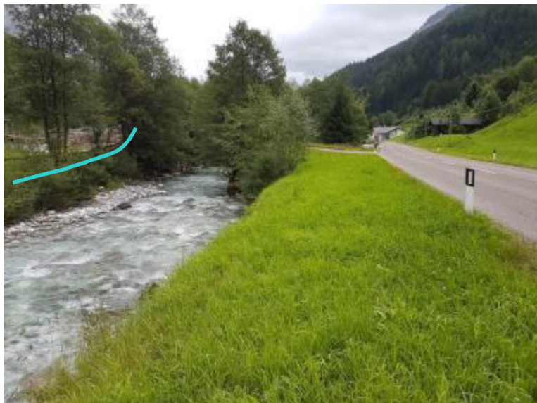
Foto 36: Die Linie kennzeichnet den Verlauf der Druckrohrleitung. Im Hintergrund die Zufahrt zum Bauhof der Elektrizitätsgenossenschaft Pflersch, welche von der Trasse gequert wird.
