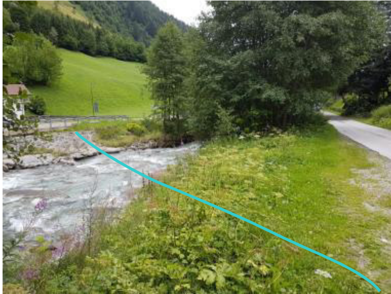
Foto 16: Die Linie kennzeichnet den Verlauf der Druckrohrleitung. Im Bild die Querung des Pflerscherbaches.
