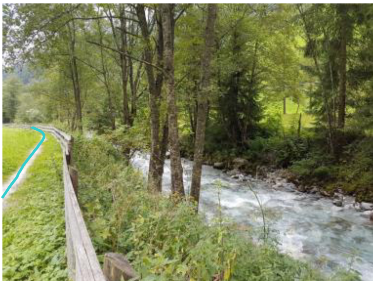
Foto 34: Die Linie kennzeichnet den Verlauf der Druckrohrleitung.
