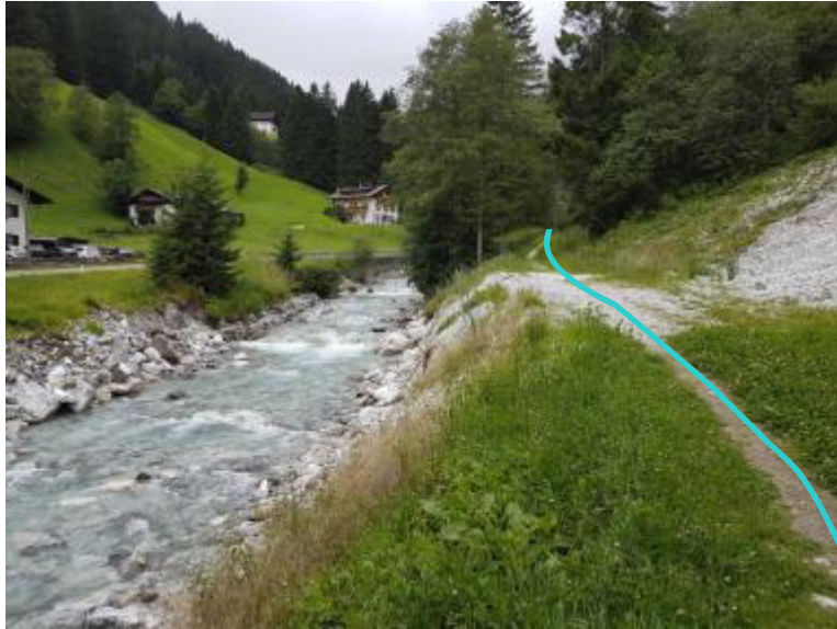
Foto 29: Die Linie kennzeichnet den Verlauf der Druckrohrleitung. Im Bild die Querung des Seitengrabens.
