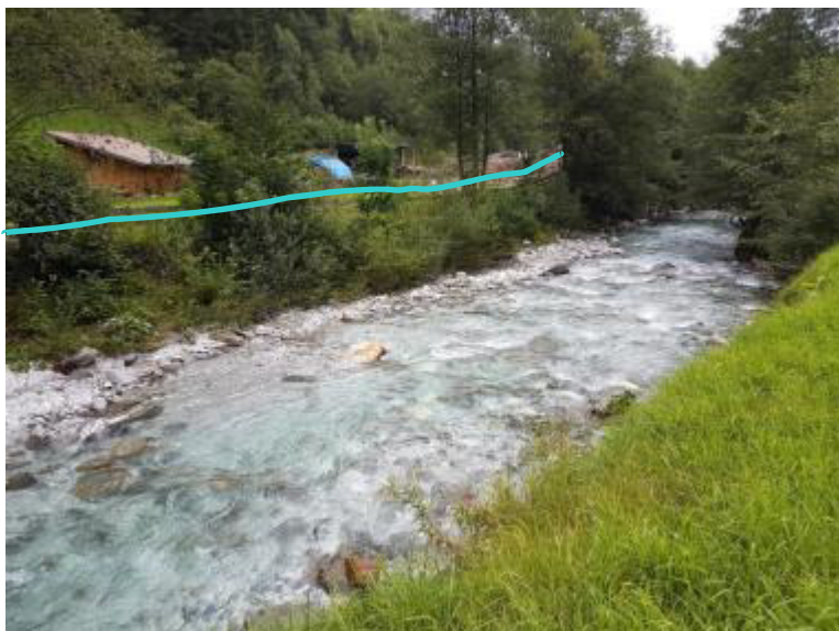
Foto 37: Die Linie kennzeichnet den Verlauf der Druckrohrleitung.
