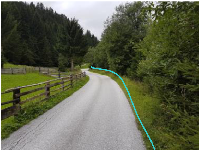
Foto 15: Die Linie kennzeichnet den Verlauf der Druckrohrleitung.
