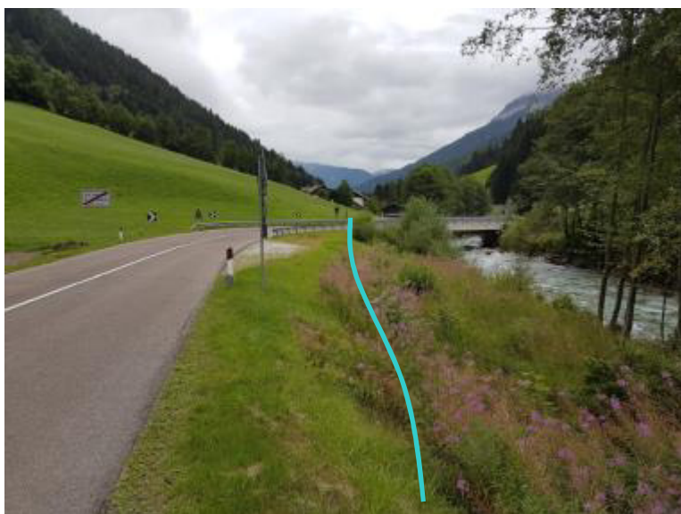
Foto 18: Die Linie kennzeichnet den Verlauf der Druckrohrleitung. Im Bild die Brücke über den Pflerscherbach und die Querung der Straße.
