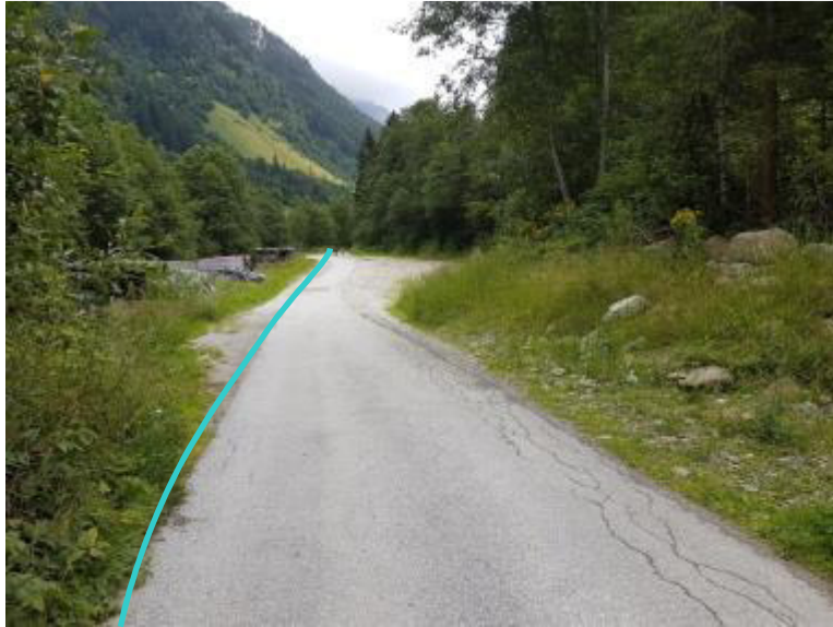
Foto 11: Die Linie kennzeichnet den Verlauf der Druckrohrleitung.
