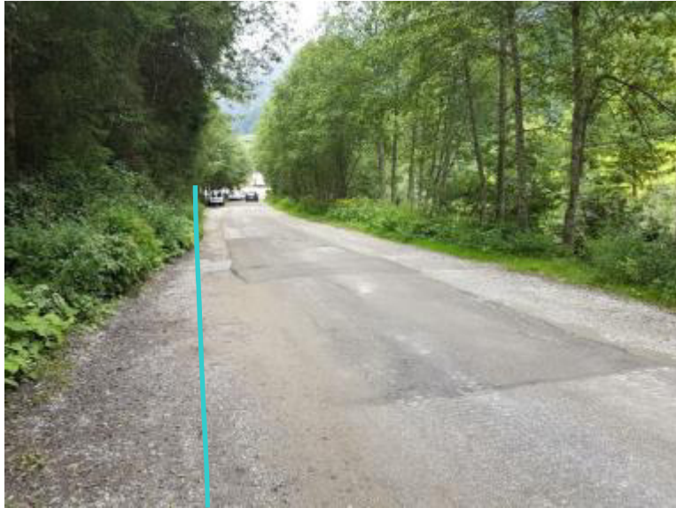
Foto 9: Die Linie kennzeichnet den Verlauf der Druckrohrleitung.
