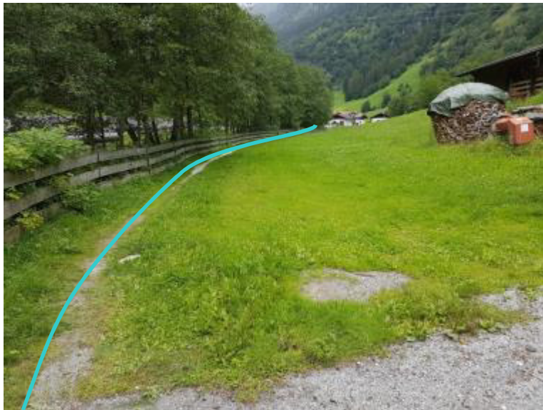
Foto 20: Die Linie kennzeichnet den Verlauf der Druckrohrleitung.
