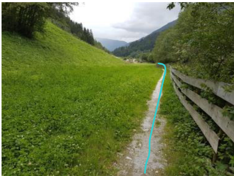
Foto 30: Die Linie kennzeichnet den Verlauf der Druckrohrleitung.
