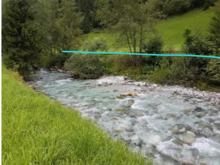
Foto 38: Die Linie kennzeichnet den Verlauf der Druckrohrleitung.
