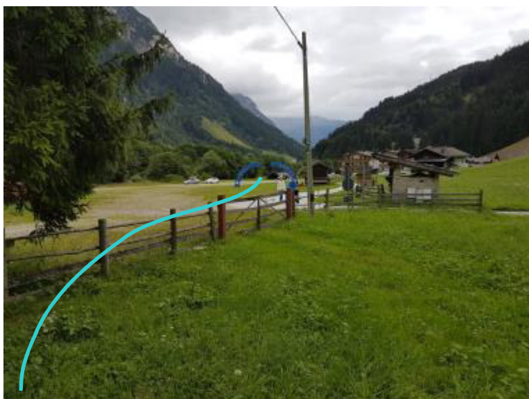
Foto 3: Die Linie kennzeichnet den Verlauf der Druckrohrleitung.
