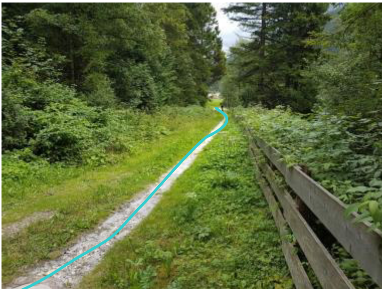
Foto 28: Die Linie kennzeichnet den Verlauf der Druckrohrleitung.
