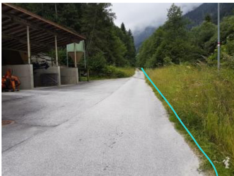
Foto 13: Die Linie kennzeichnet den Verlauf der Druckrohrleitung.
