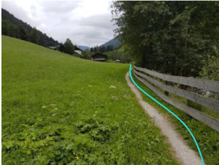
Foto 19: Die Linie kennzeichnet den Verlauf der Druckrohrleitung.
