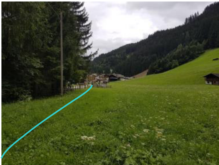
Foto 2: Die Linie kennzeichnet den Verlauf der Druckrohrleitung.
