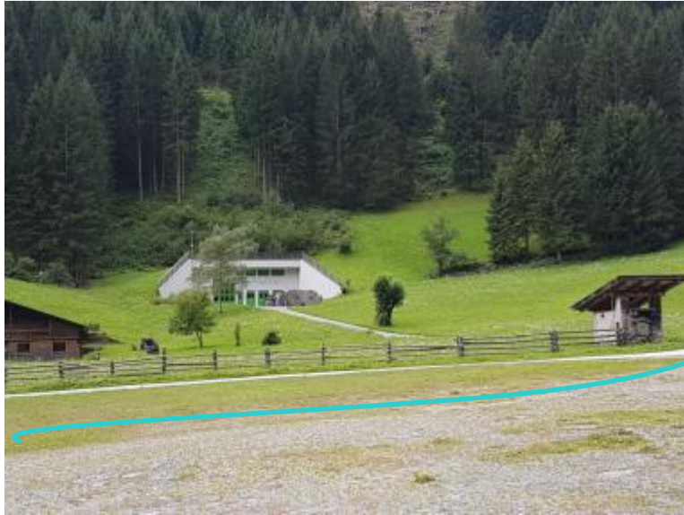
Foto 4: Die Linie kennzeichnet den Verlauf der Druckrohrleitung. Im Hintergrund das Krafthaus Stein.
