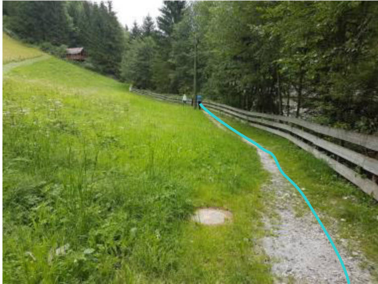
Foto 24: Die Linie kennzeichnet den Verlauf der Druckrohrleitung.
