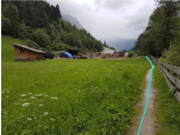
Foto 35: Die Linie kennzeichnet den Verlauf der Druckrohrleitung.
