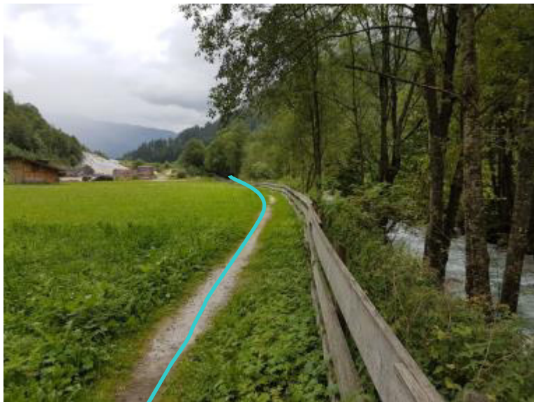
Foto 33: Die Linie kennzeichnet den Verlauf der Druckrohrleitung.
