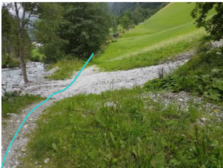
Foto 23: Die Linie kennzeichnet den Verlauf der Druckrohrleitung. Im Bild die Querung eines weiteren Seitengrabens.
