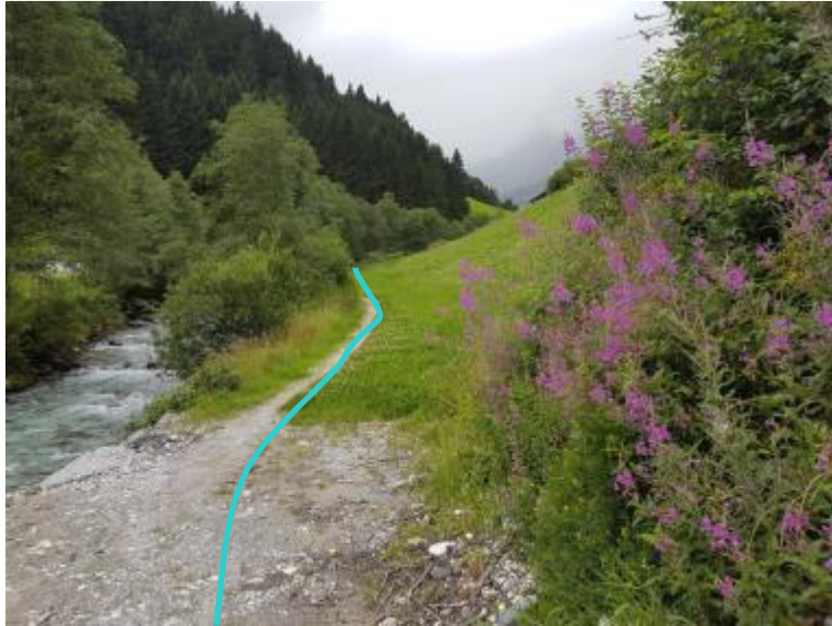
Foto 21: Die Linie kennzeichnet den Verlauf der Druckrohrleitung. Im Bild die Querung des Seitengrabens.
