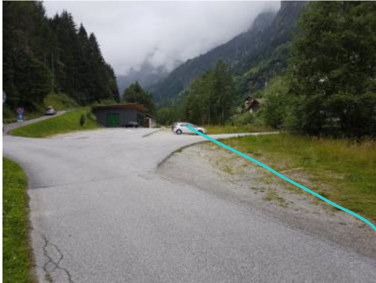
Foto 14: Die Linie kennzeichnet den Verlauf der Druckrohrleitung. Im Bild die Kreuzung der Brücke über den Pflerscherbach und der Zufahrt zur Alrissalm.
