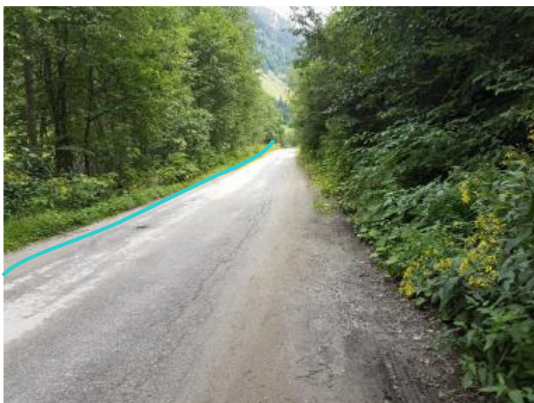
Foto 8: Die Linie kennzeichnet den Verlauf der Druckrohrleitung.
