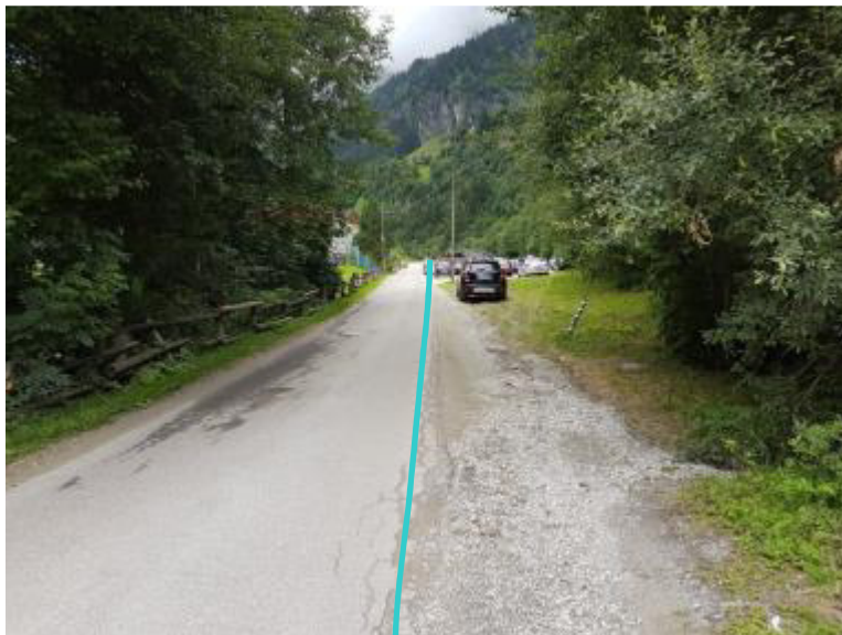
Foto 7: Die Linie kennzeichnet den Verlauf der Druckrohrleitung.
