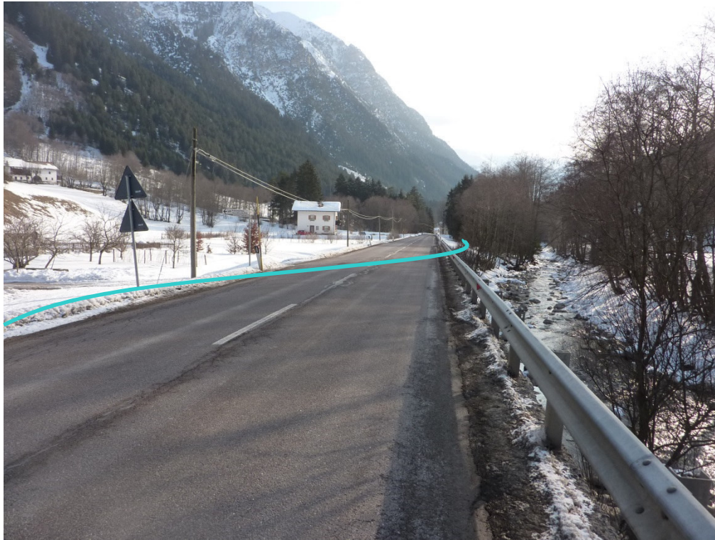
Foto 1: Die Linie kennzeichnet den Verlauf der Druckrohrleitung. Im Bild die geplante Straßenquerung
