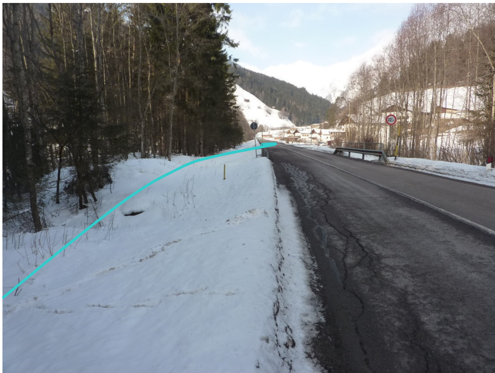
Foto 2: Die Linie kennzeichnet den ungefähren Verlauf der Druckrohrleitung.
