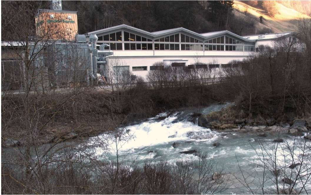
Abb 12: Sohlstufe im Mündungsbereich des St. Vilgilbach
