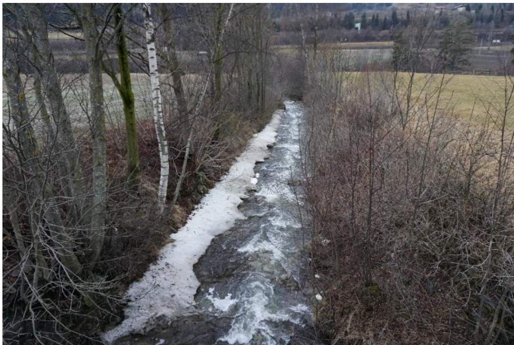
Abbildung 8: Abschnitt 1 - gepflastert und begradigt
