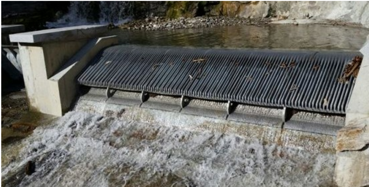
Abbildung 7: Beispiel für ein Tiroler Wehr mit Coandasieb
