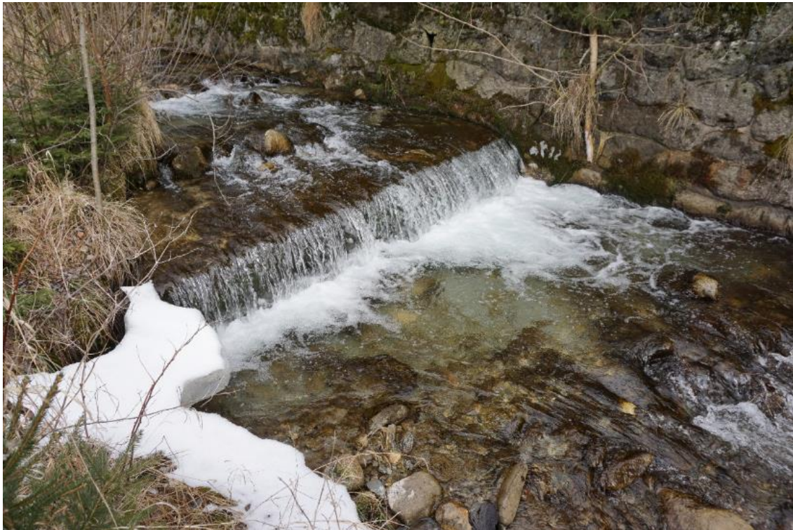
Abbildung 11: Querbauwerk und relativ breite Bachsohle mit niedriger Fließtiefe
