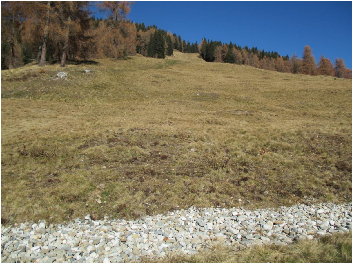
Abbildung 9: Drainagegraben und bestehende Skipiste Breiteben
