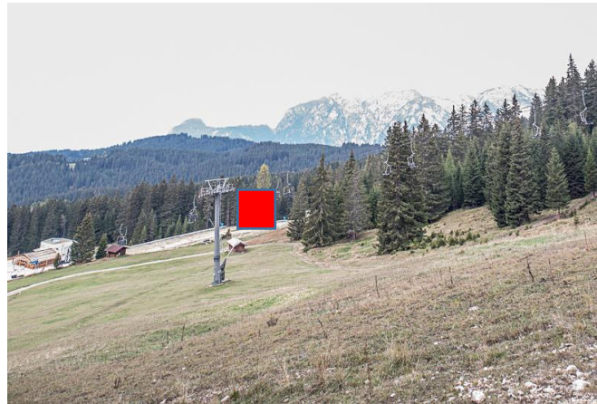
Foto 11: Blick auf den Standort der Talstation von der Skipiste aus; von diesem Bereich aus bestehen auch Sichtbeziehungen zur Liftanlage; Lage der Bergstation bei der Frommer Alm (rot markiert)
