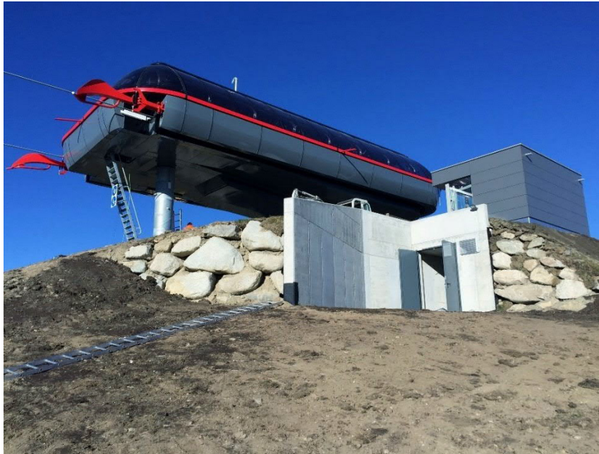
Foto 2: Bereich der bestehenden Bergstation
