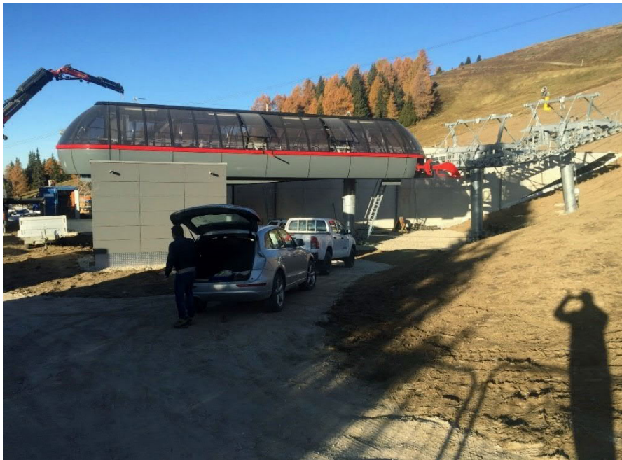
Bild 1: Bereich der bestehenden Talstation
