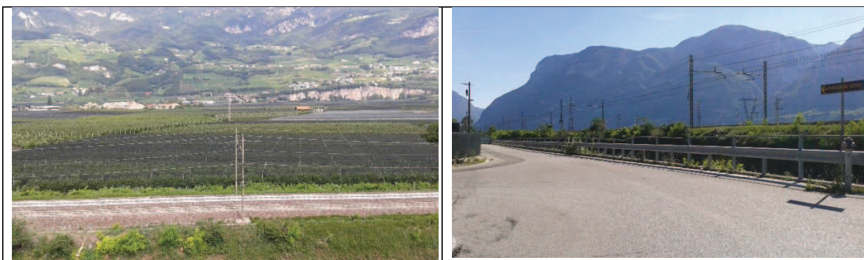
Figura 3.2.4 - Contesto territoriale: rilevato ferroviario e meleti.
