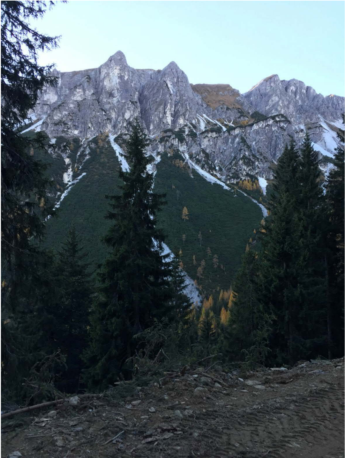
Foto 1: Blick von Talstation zur Mittelstation auf dem Gebirgskamm „Gschleier“
