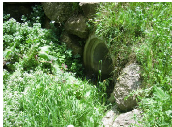
(d) Verrohrung im mittleren Abschnitt der Skipistenverbindung
