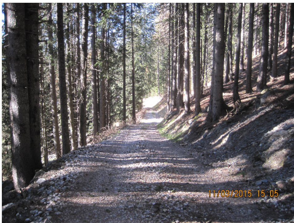
Foto 1.4: oberer Abschnitt - Blick entlang bestehendem Forstweg tratto a monte - sguardo rivolto lungo il proseguimento della strada forestale
