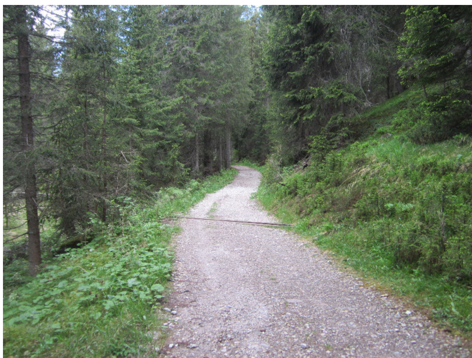
Foto 3.9: Adaptierung des bestehenden Forstweges im unteren Abschnitt adattamento della strada forestale esistente nel tratto a valle
