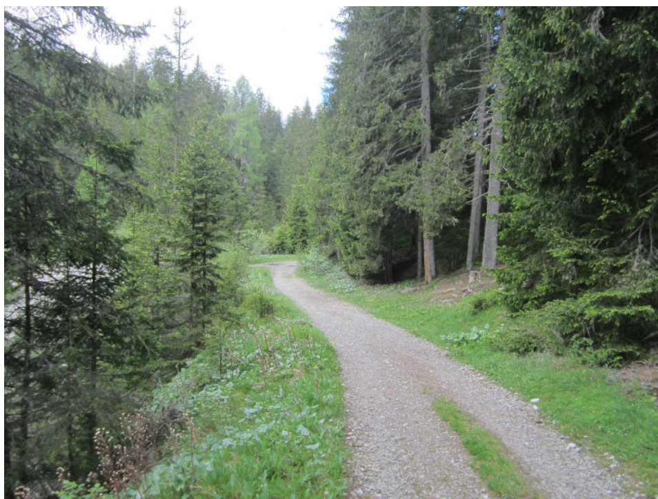
Foto 3.12: Adaptierung des bestehenden Forstweges im untersten Abschnitt entlang des Sextnerbaches adattamento della strada forestale esistente nel tratto a valle lungo il Rio Sesto
