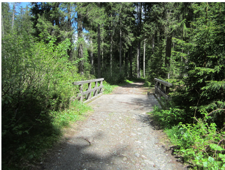
Foto 3.13: Brücke über den Klambach im untersten Abschnitt ponte di attraversamento del Rio Klambach nel tratto a valle
