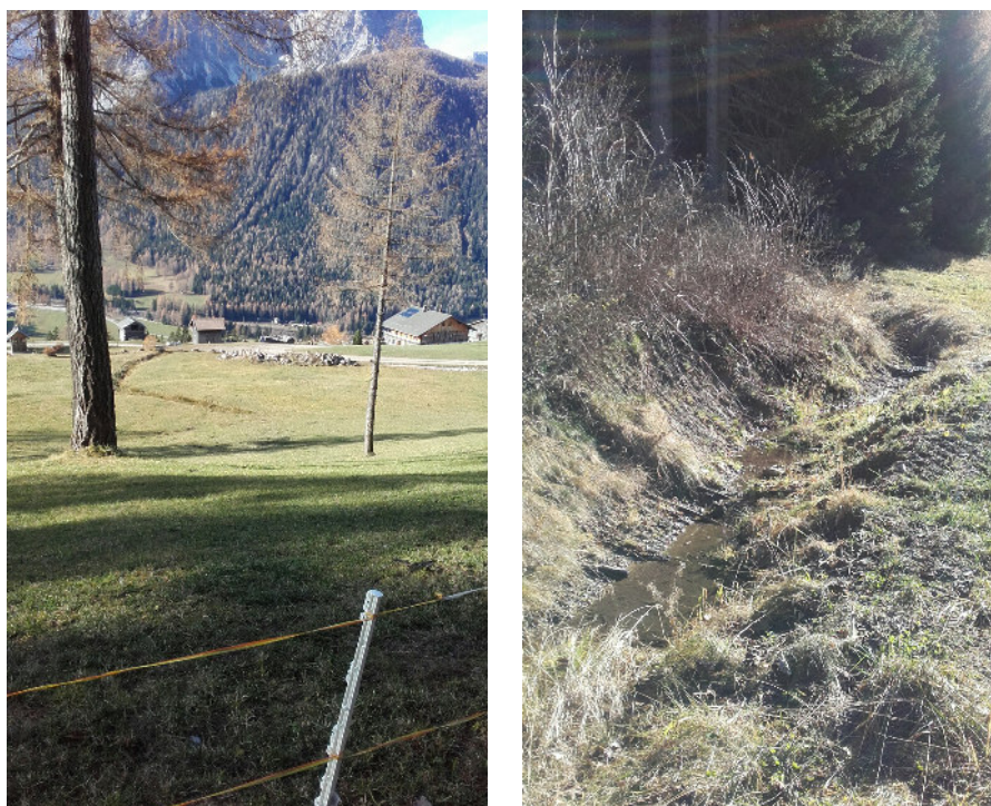
Foto 1.8: Bestehende Dränagen Bereich „Fronebner“ drenaggio esistente zona "Fronebner"
