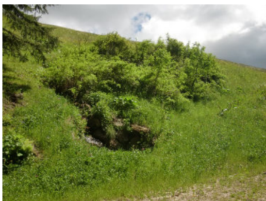
(c) Fuoriuscita d'acqua nella parte centrale della pista di collegamento
