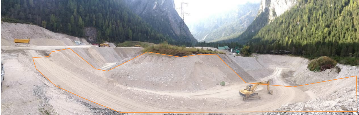
Fläche C: der Bereich der sichtbaren Rampe bis ca. zum Standort des Baggers rechts soll verfüllt werden.
