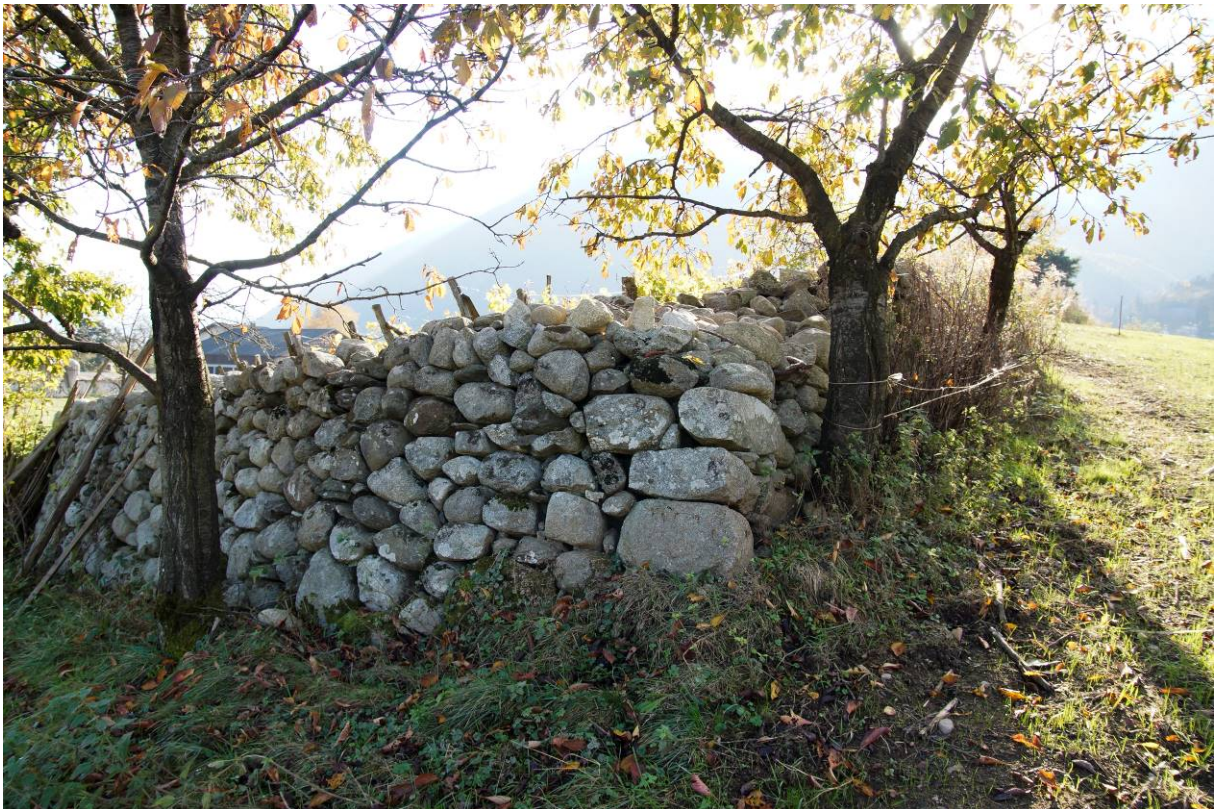
Abbildung 13: Instandgehaltene Trockensteinmauer (östlicher Eckbereich)
