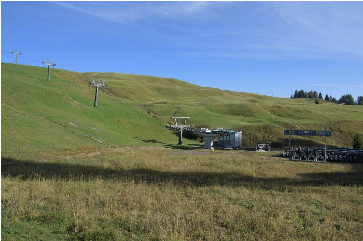
Abbildung 25: Leicht vernässter, bzw. ursprünglich vernässter Bereich an der abzubrechenden Talstation
