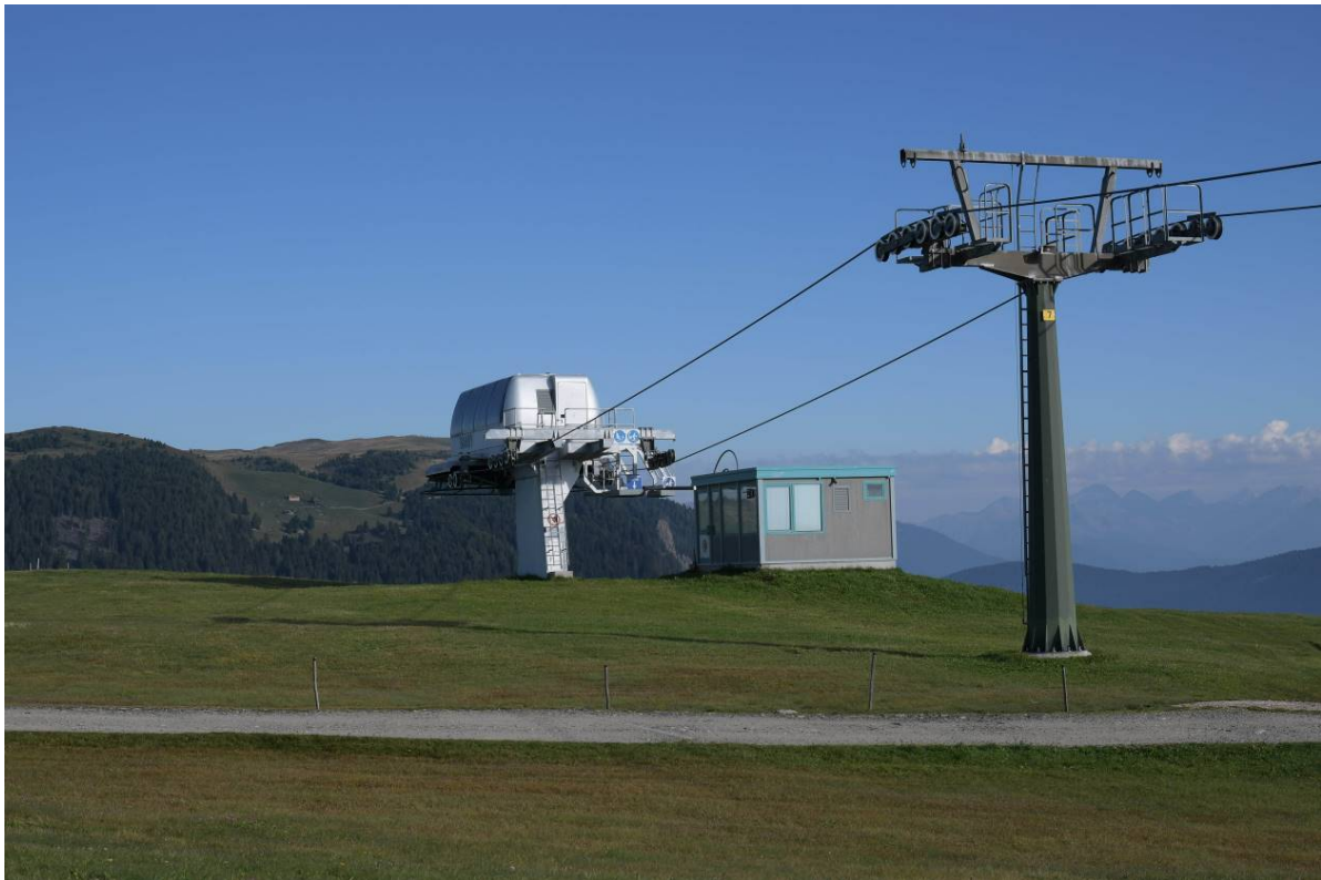
Abbildung 22: Bergstation Sesslift Bamby (Bestand abzubrechen)
