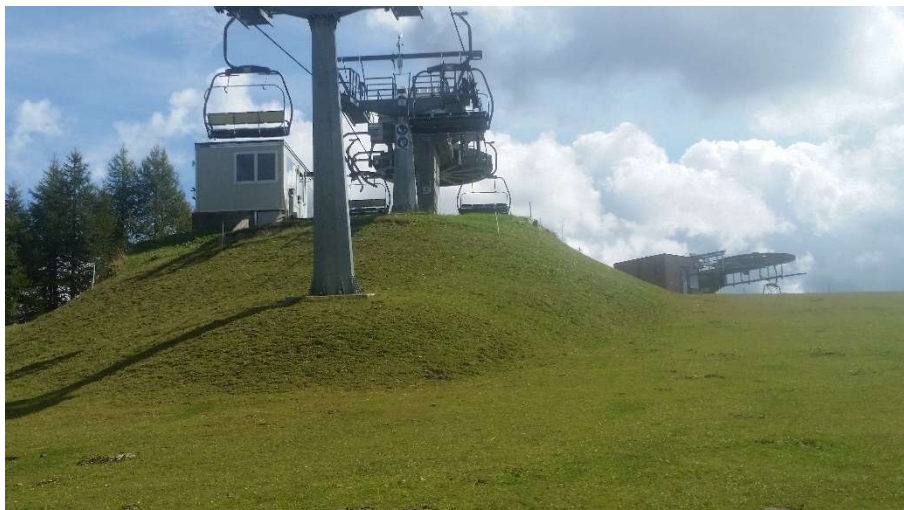
Abbildung 5: Bergmähwiese im Bereich der Bergstation
