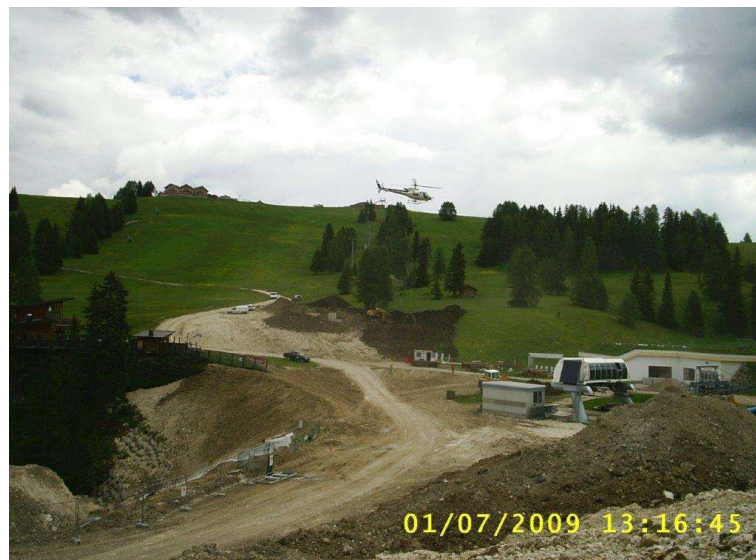
Abbildung 2: Bauarbeiten im Jahre 2009
