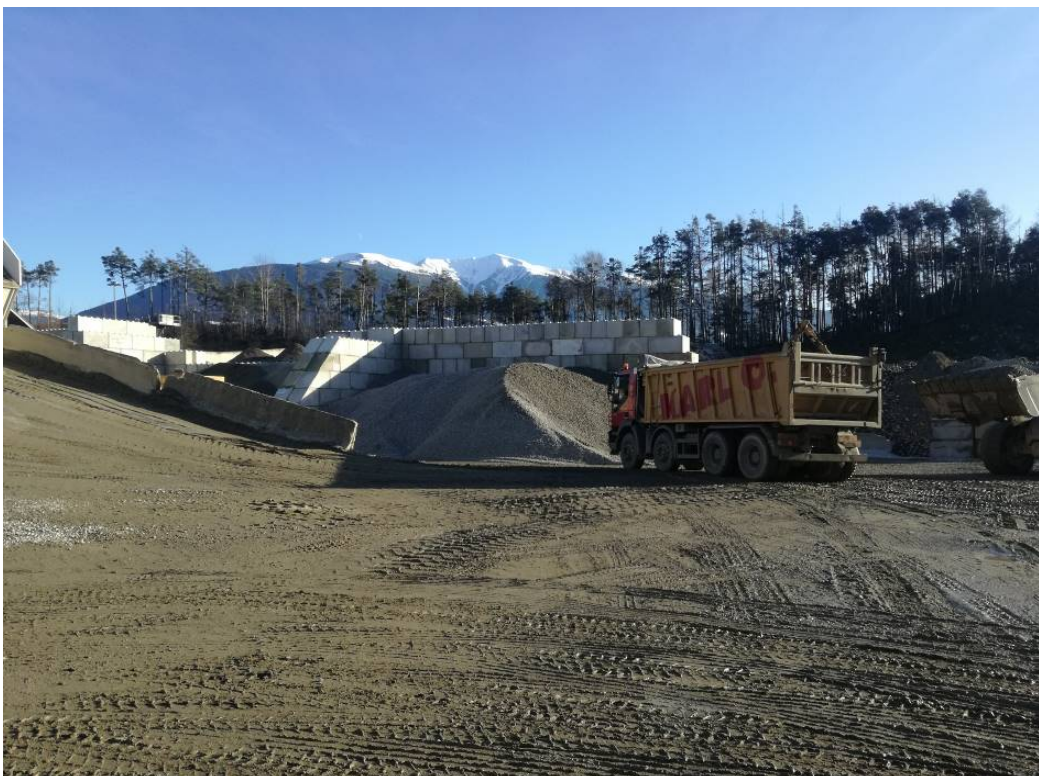
Abbildung 9: Ungefestigte Rangierflächen im zentralen Bereich
