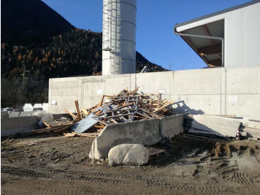
Abbildung 8: Lagerung von Altholz
