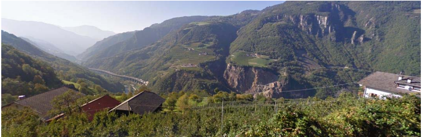
Figura 2.1.22 Vista in direzione della Valle d'Isarco nel Comune di Fiè allo Sciliar
