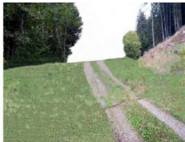
Tratto pista sezione 41-43 visto da valle.
