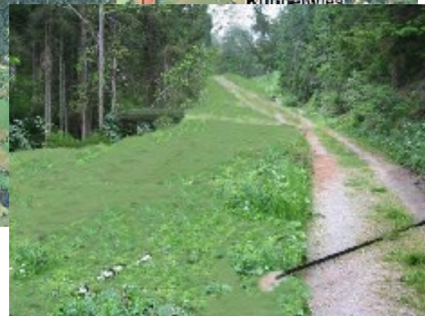
Tratto pista sezione 37-42 visto da valle.
