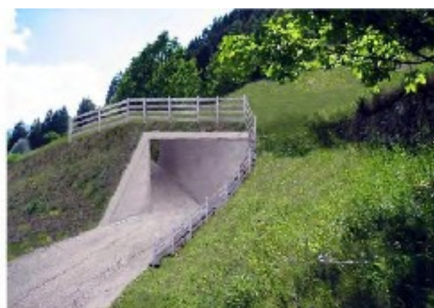
Strada Schwienberg sovrappasso pista sezione 22-21bise 21 vista da nord.
