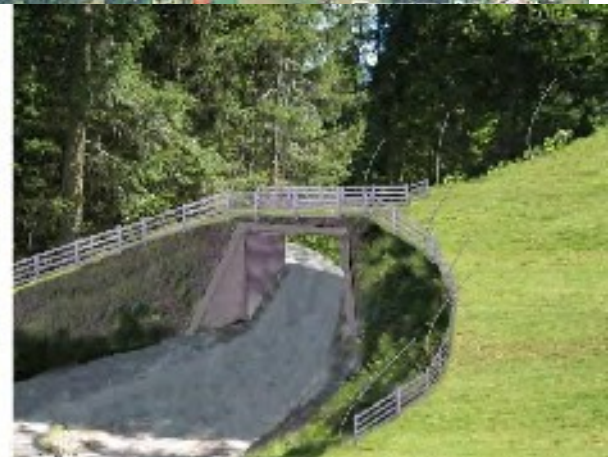
La strada forestale da S. Maurizio, che funge in inverno come Skiweg verrà inserita in tunnel per poterla sovrappassare con la pista. (sezione 70)
