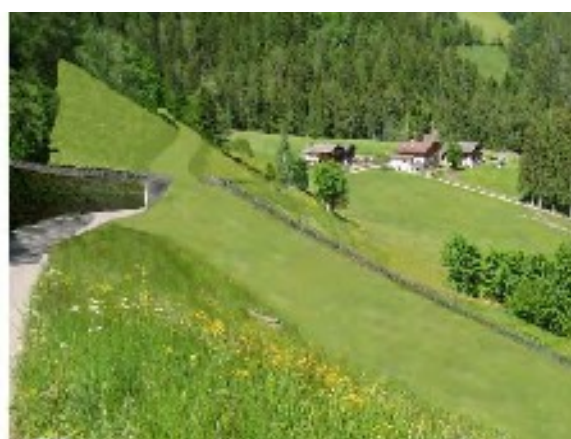
Strada Schwienberg sovrappasso pista sezione 21-21bise e22 vista da sud.
