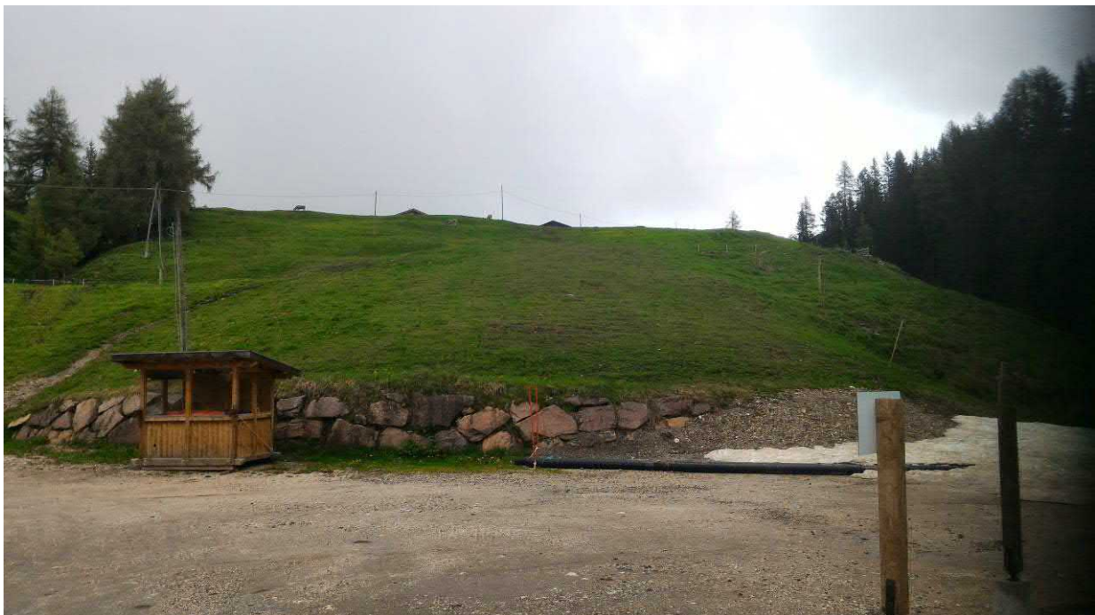
Foto 3: Bereich der Talstation und Zubringerpiste wo Arbeiten durchgeführt werden
