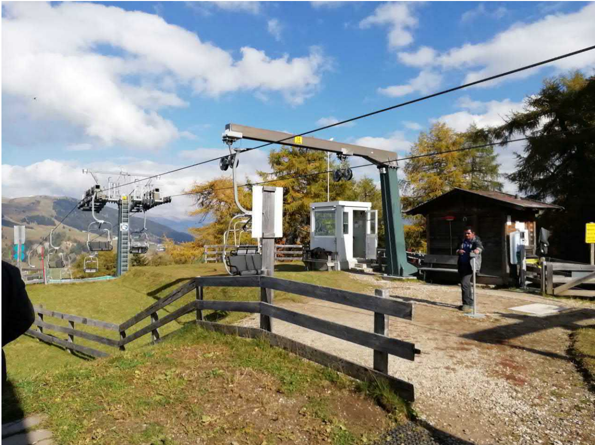
Foto 4: Bereich der geplanten Bergstation
