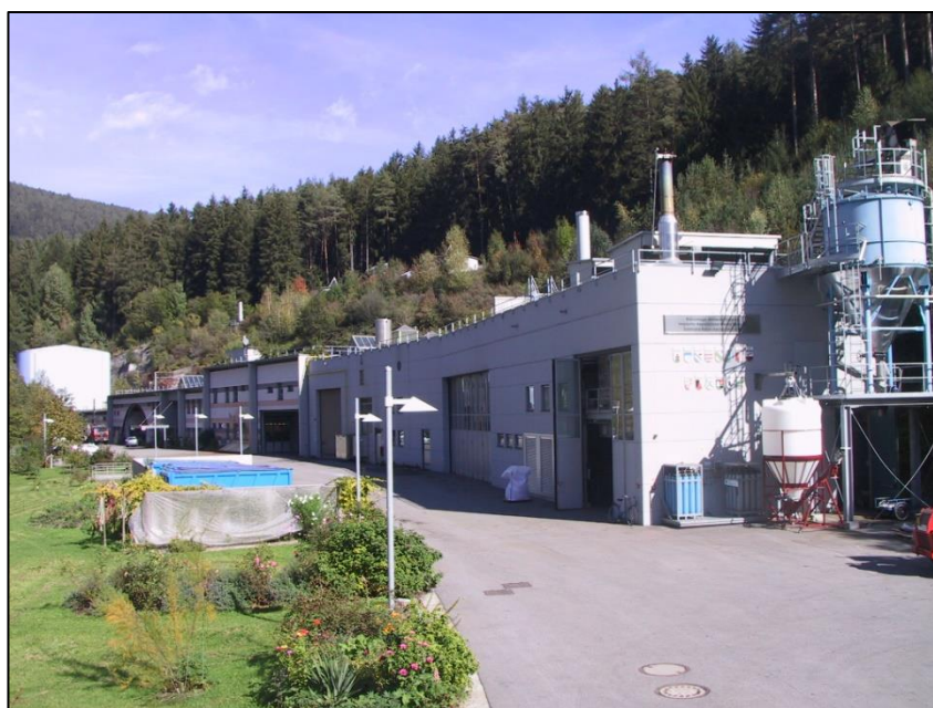
Fig.2 Vista dell'impianto ARA / IDA Tobl
