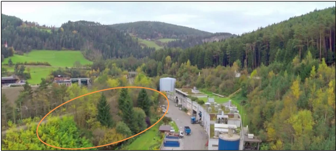
Fig. 33 Piantumazione presso la rampa della Ferrovia della Pusteria
