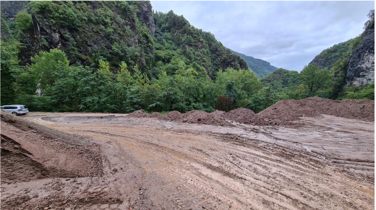
Foto 1 Zufahrt zum Projektgebiet – Arbeiten des Vorprojekts ersichtlich
