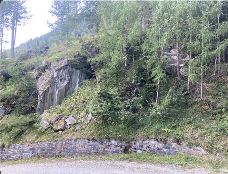
Abbildung 4: unterer Bildrand: die Schlüsseljochstraße; Bildmitte: die geplante Erweiterungsfläche zum Abbau des Bockgerüstes.
