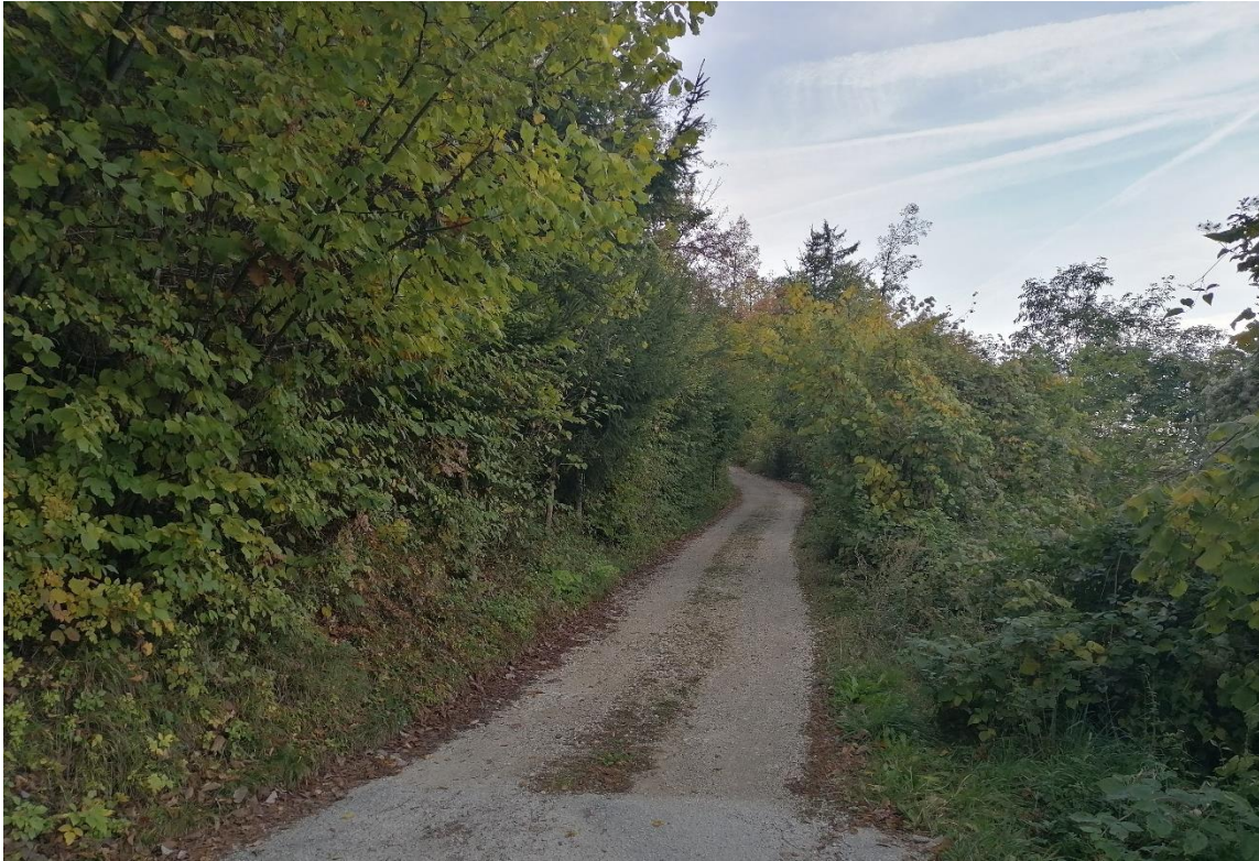
Abbildung 16: Gemeinsame Einmündung der geplanten Zufahrt und des bestehenden Forstweges in die bestehende Straße
