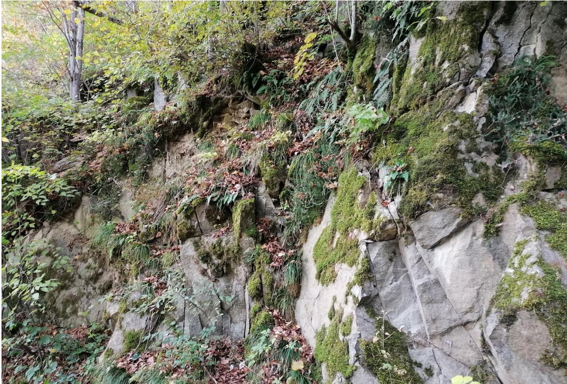
Abbildung 30: Aufgeschlossener Porphyr-Fels im Bereich des bestehenden Forstweges (oberhalb geplanter Zufahrt)
