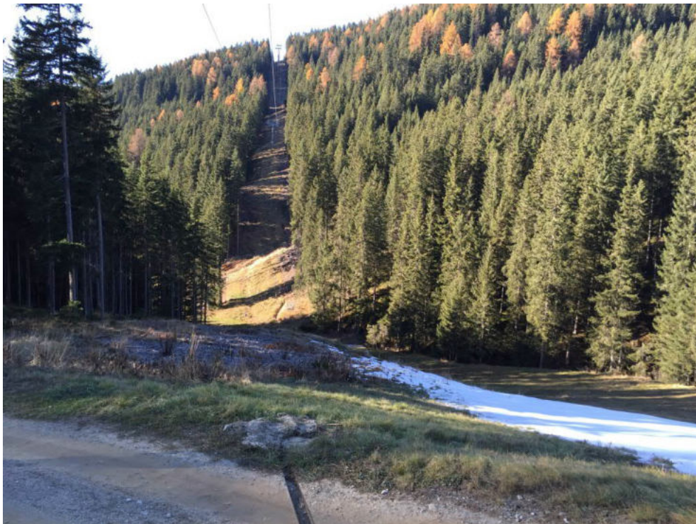
Foto 1.37: Blick von bestehender Mittelstation in Richtung geplante Talstation - G35
