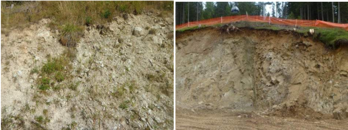
Abb. 3 Links: Stark aufgelockerter und verwitterter Granit oberhalb der Almen „Gampen“; Rechts: Aushub an der Talstation Gaisjochbahn (Sommer 2011) in verwittertem bzw. stark zerlegtem Granit, im unteren Aushubabschnitt ist das ursprüngliche Felsgefüge größtenteils noch erhalten.
