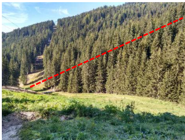
Talstation und unterer Trassenabschnitt der Aufstiegsanlage
