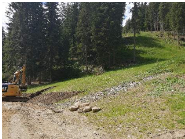
Standort der vorgesehenen Talstation, am linken Bildrand die bestehende Talabfahrt.
