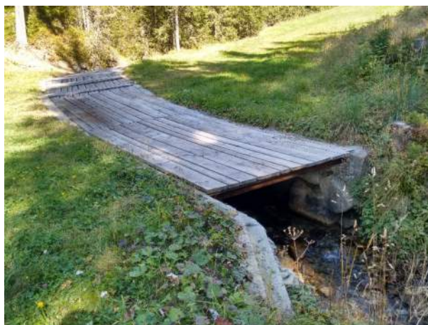
Pistenquerung Endereckbach nordöstlich des Standorts.
